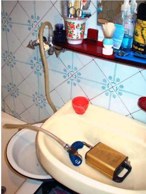
Foto 2.2. Măsurările debitului de apă în apeductul (în apartamentul a consumatorului)
