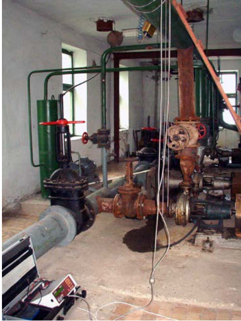
Des. 2.1. Măsurările debitului de apă în apeductul de presiune a stației de pompare.
