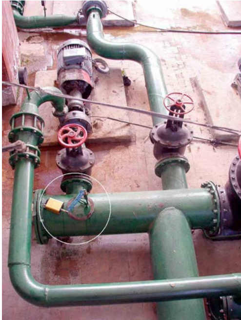
Foto 2.4. Măsurarea presiunii pe țeava de refulare.
