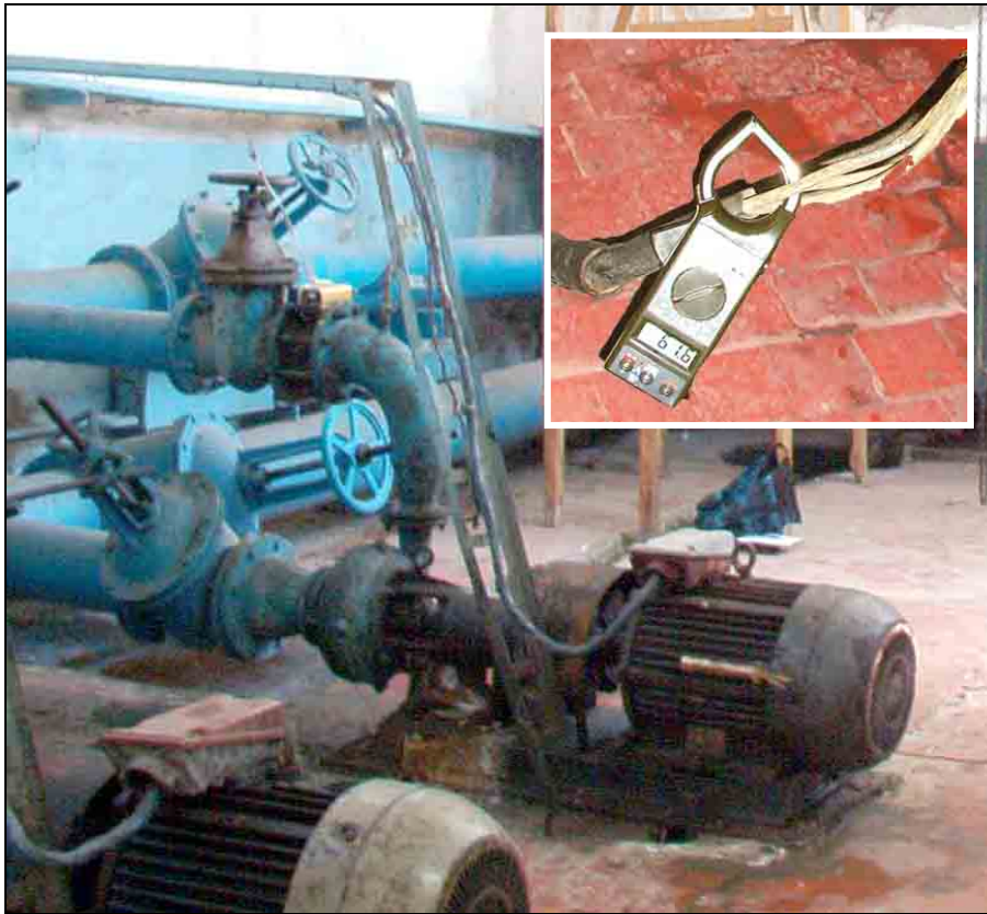
Фото 2.3. Замеры напряжения и силы тока на электродвигателе насосного агрегата.
