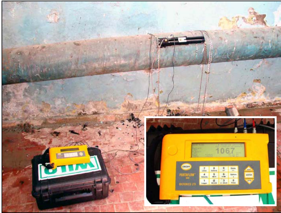
Фото 2.1. Замеры расхода воды в напорном трубопроводе насосной станции.
