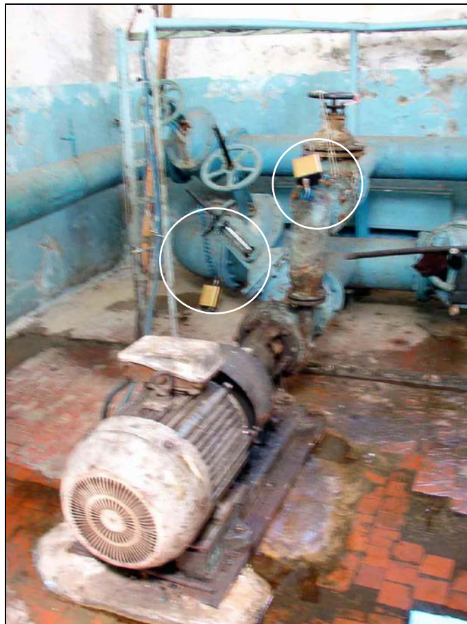
Фото 2.2. Замеры давления воды в напорном и всасывающем трубопроводе насосной станции.
