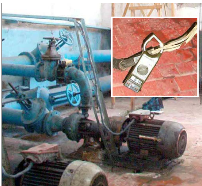
Foto 2.3. Măsurarea tensiunii și curentului la electromotor..
