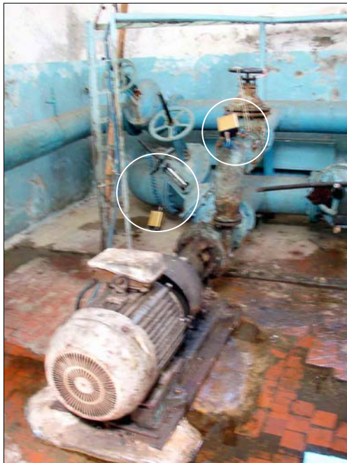
Foto 2.2. Măsurările presiunii apei în țeava de aspirație și refulare la stație de pompare
