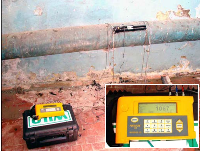
Foto 2.1. Măsurările debitului de apă în apeductul de presiune a stației de pompare
