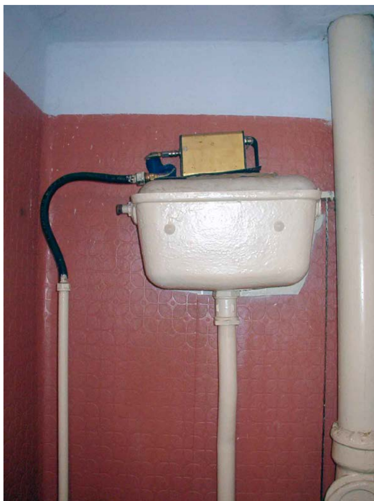
Фото 2.2. Замеры давления воды в водопроводе (в квартире у потребителя).
