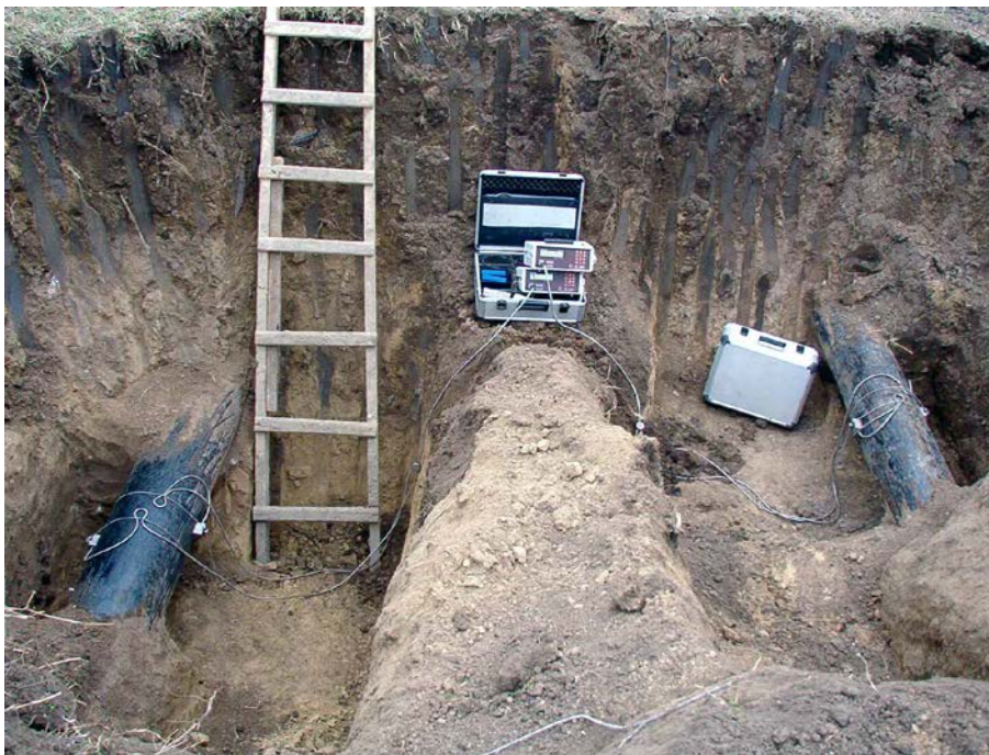
Фото 2.1. Замеры расхода воды (в шурфе) на 2-х напорных трубопроводах.
