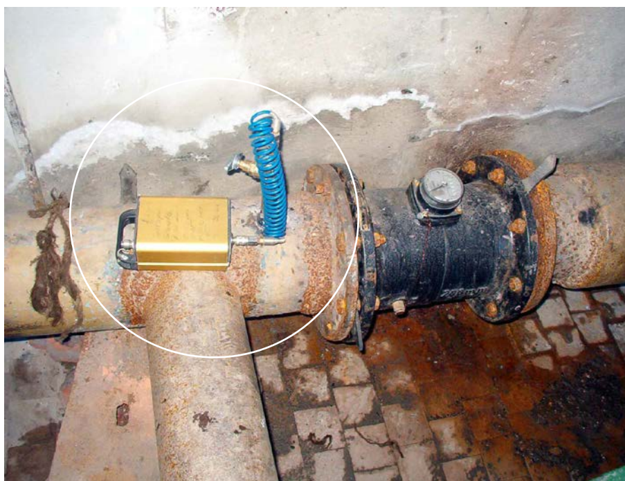
Фото 2.4. Замеры давления в напорном трубопроводе насосной станции.
