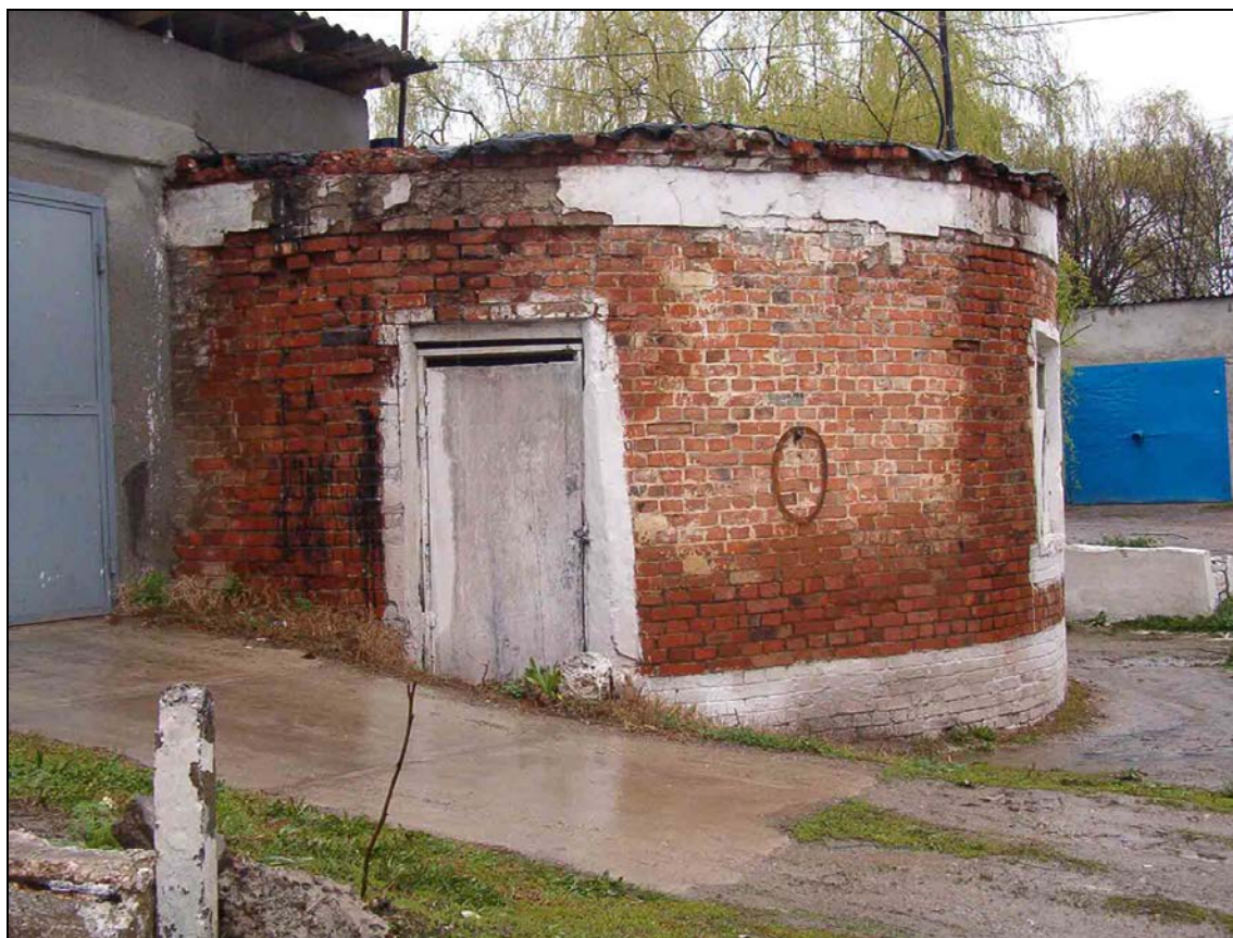
Foto 2.1. or.Hîncești. SRPC. Vederea principală a stației de pompare.
