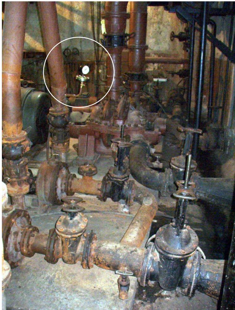
Фото 2.4. Замеры давления в напорном трубопроводе (с использованием мембранного манометра).
