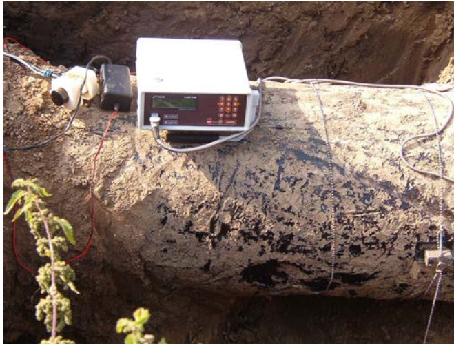
Foto 2.1. Măsurarea debitului de apă (în canal) pe rețeaua de rețurare.
