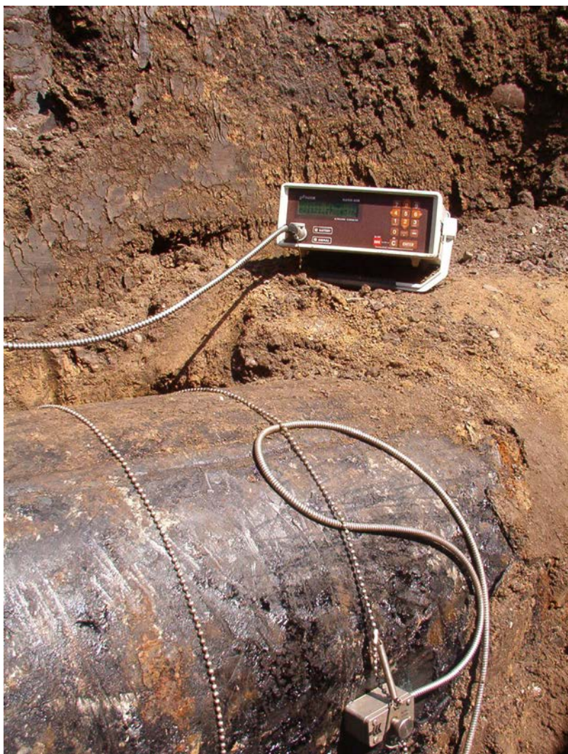
Фото 1.3.1. Замеры расхода воды в трубопроводе (в шурфе).
