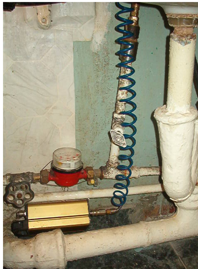
Фото 1.3.2. Замеры давления воды в водопроводе в квартире у потребителя.
