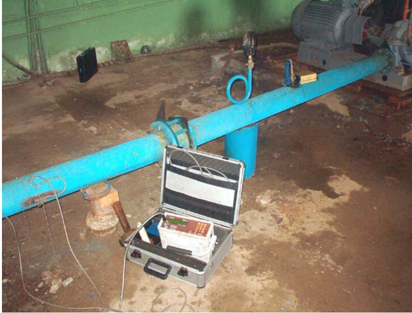
Foto 1.3.3. Măsurarea debitului apei și presiunii în conductă la stația de pompare.
