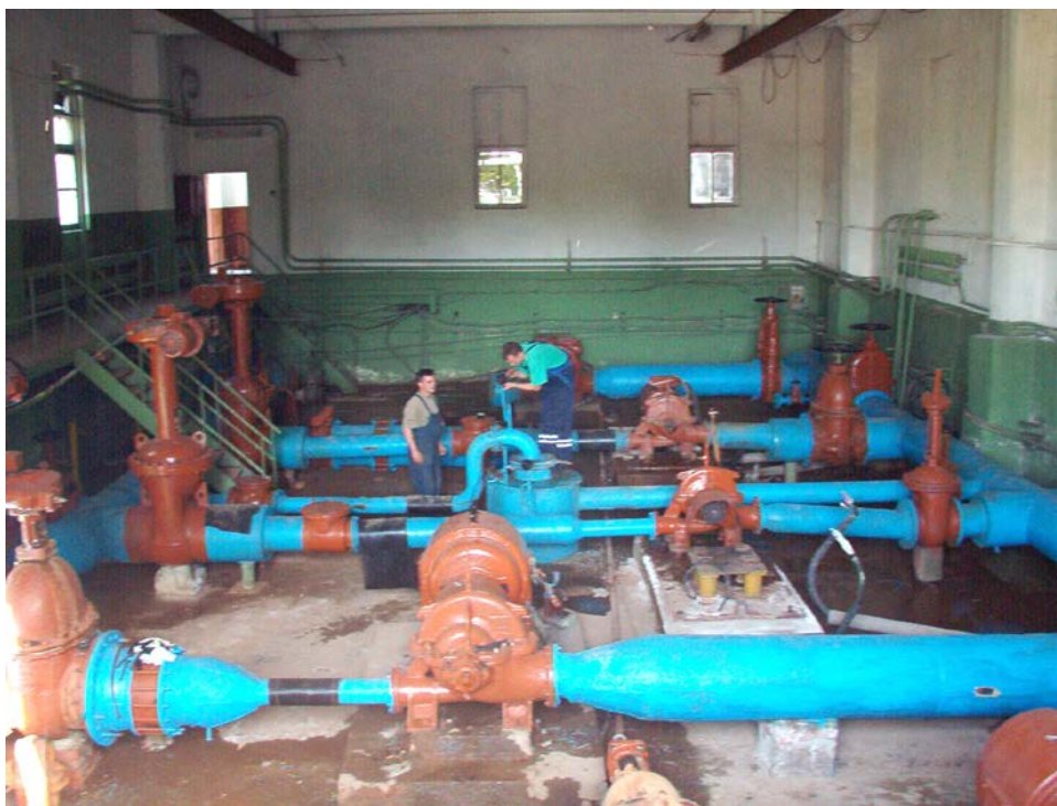
Foto 1.2.1. mun. Bălți. SP „Ciarupin”. Sala de mașini.
