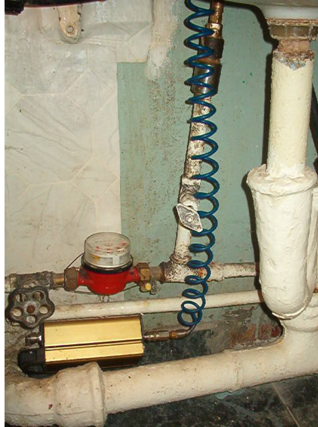
Foto 1.3.2. Măsurarea presiunii a apei în conductă în apartamentul a consumătorul
