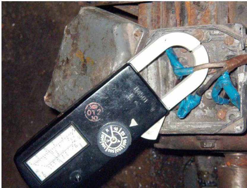
Foto 1.3.4. Măsurarea tensiunii și intensității curentului
