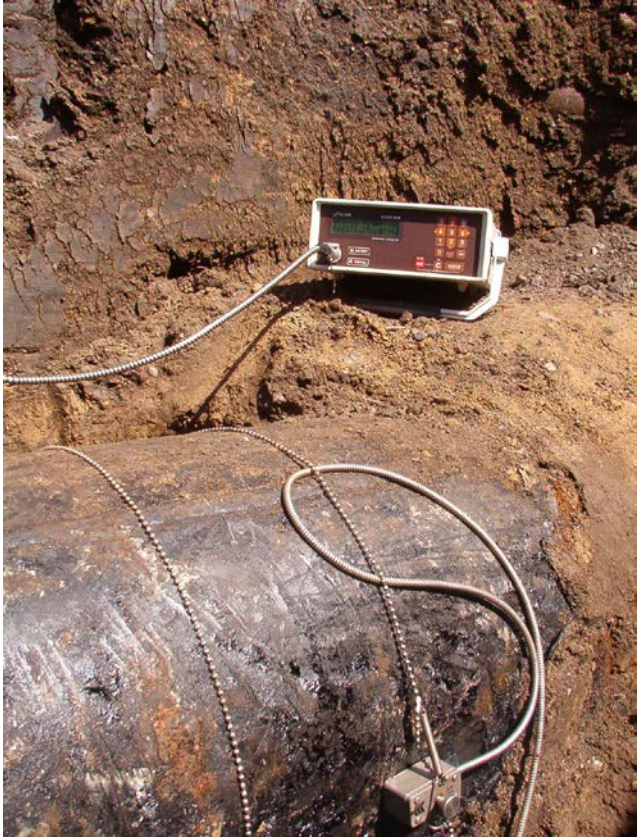
Foto 1.3.1. Măsurarea debitului apei în conductă la puț.
