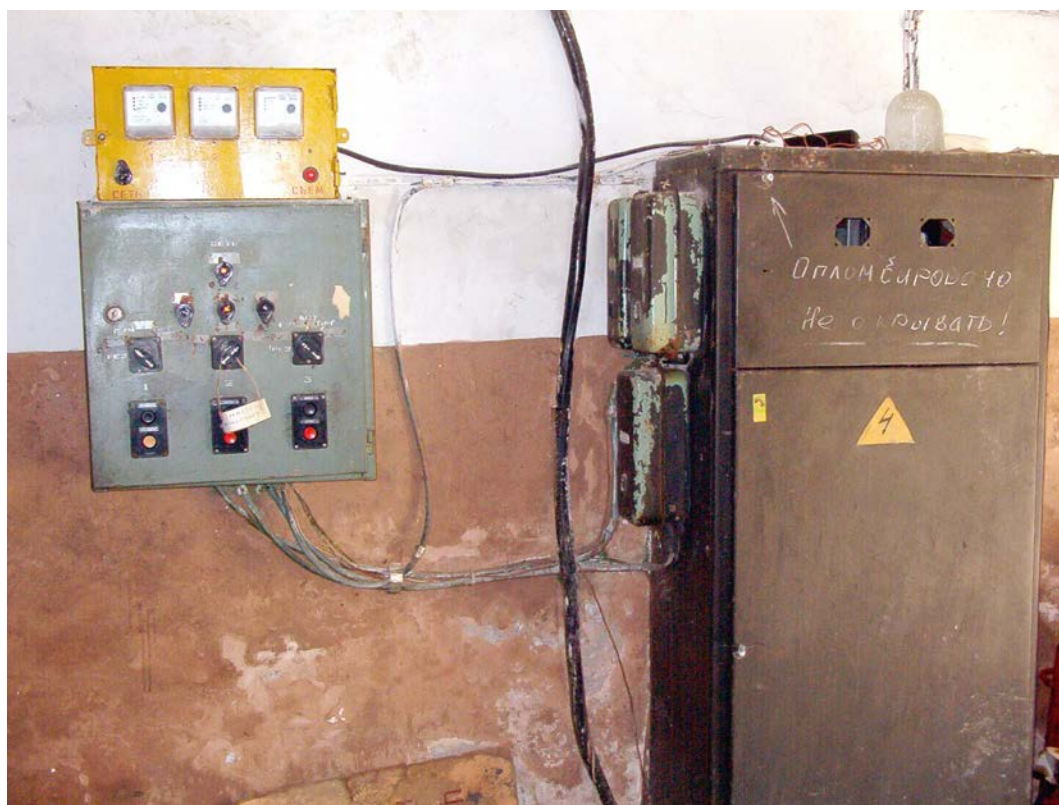
Фото. 3.2. г. Бельц. ПНС «Конева-24». Щит управления и силовой шкаф.
