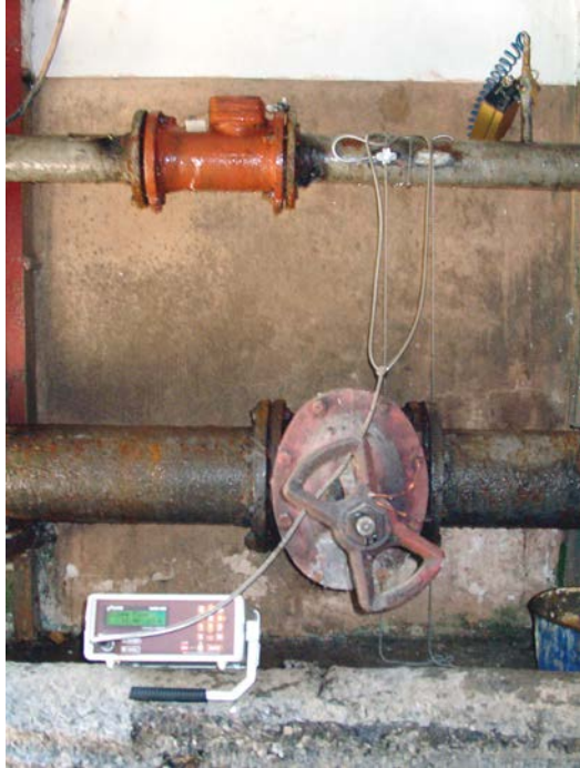
Foto 1.3.1. Măsurarea debitului apei și presiunii în conductă la stația de pompare.
