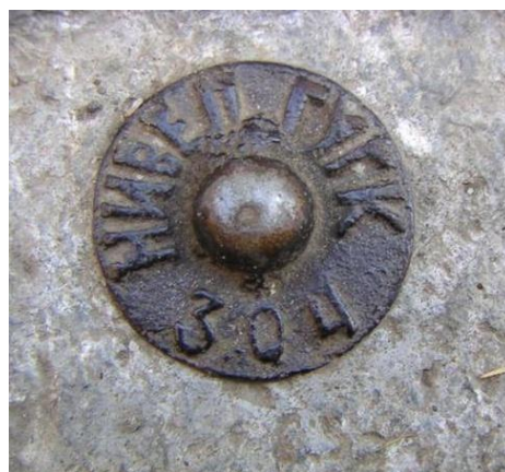
Рис. 7.25. Фото государственного грунтового репера, установленного в горной местности
