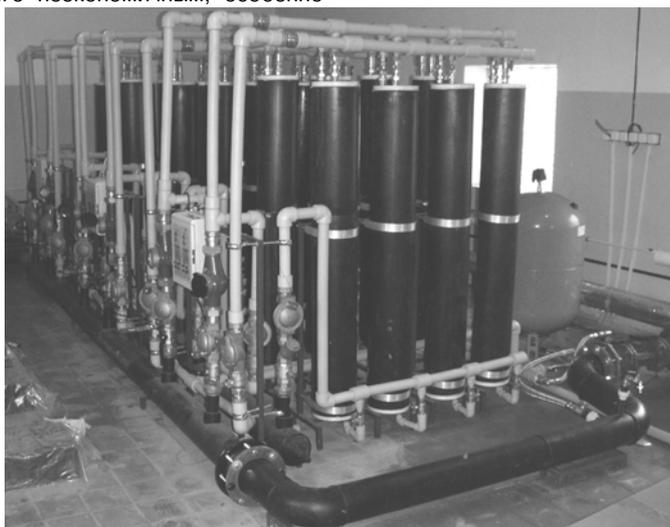
Рис. Внешний вид станции обезжелезивания производительностью 2000 м<sup>3</sup>/сутки (мембранные блоки с узлом промывки).
