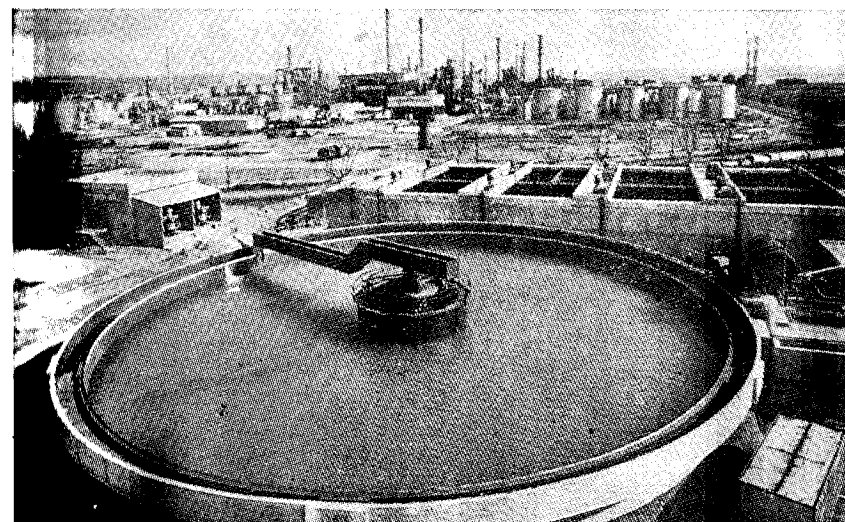
Рис. 25.16. Обработка стока нефтехимического завода. Средняя производительность 650 м 3 /ч
