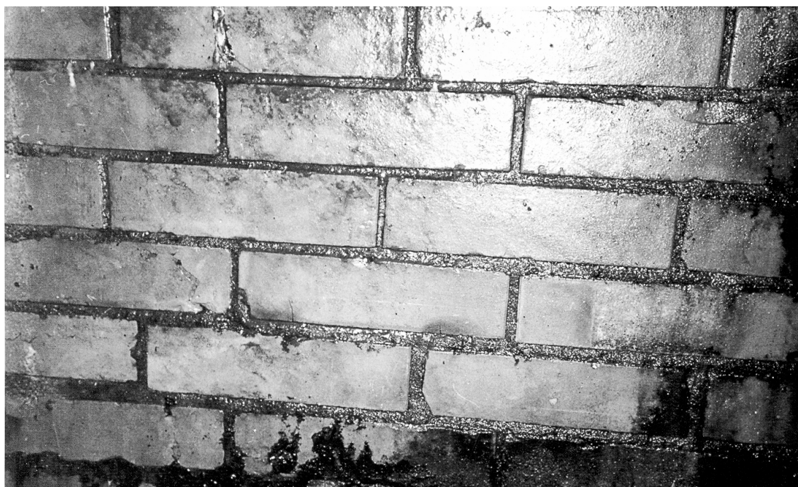
Рис. 1.51. Стена смотрового колодца из клинкерного кирпича, на действующем коллекторе построенного в г. Харькове в начале XX века.
