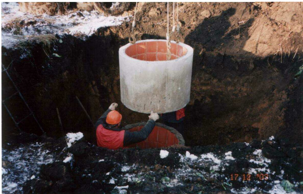
Рис. 9.2. Монтаж кольца смотрового колодца.
