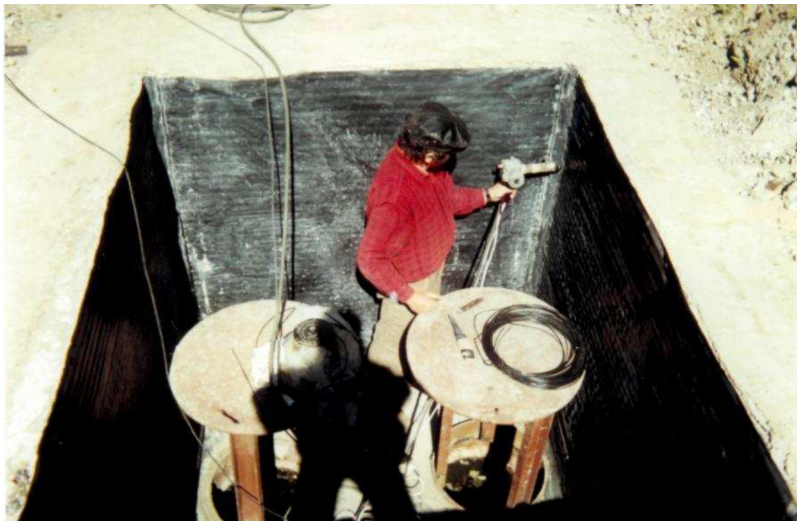
Рис. 9.7. Сваривание стыков полиэтилена.
