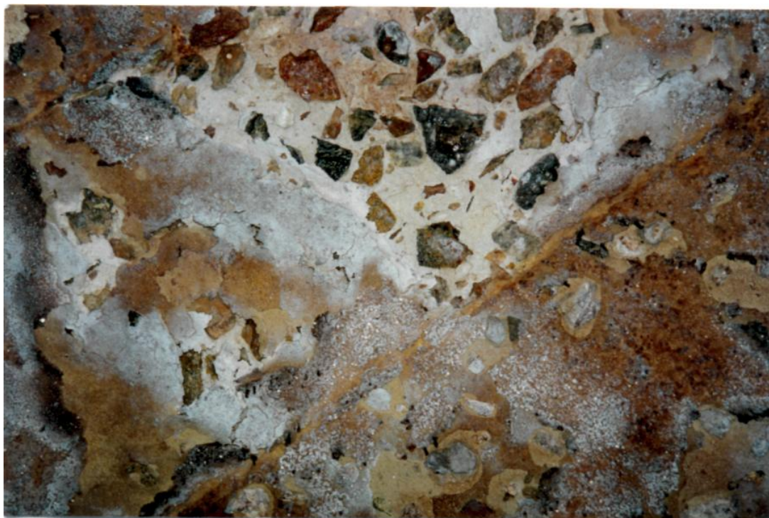
Рис. 4.8. Коррозия бетонной обделки тоннеля
