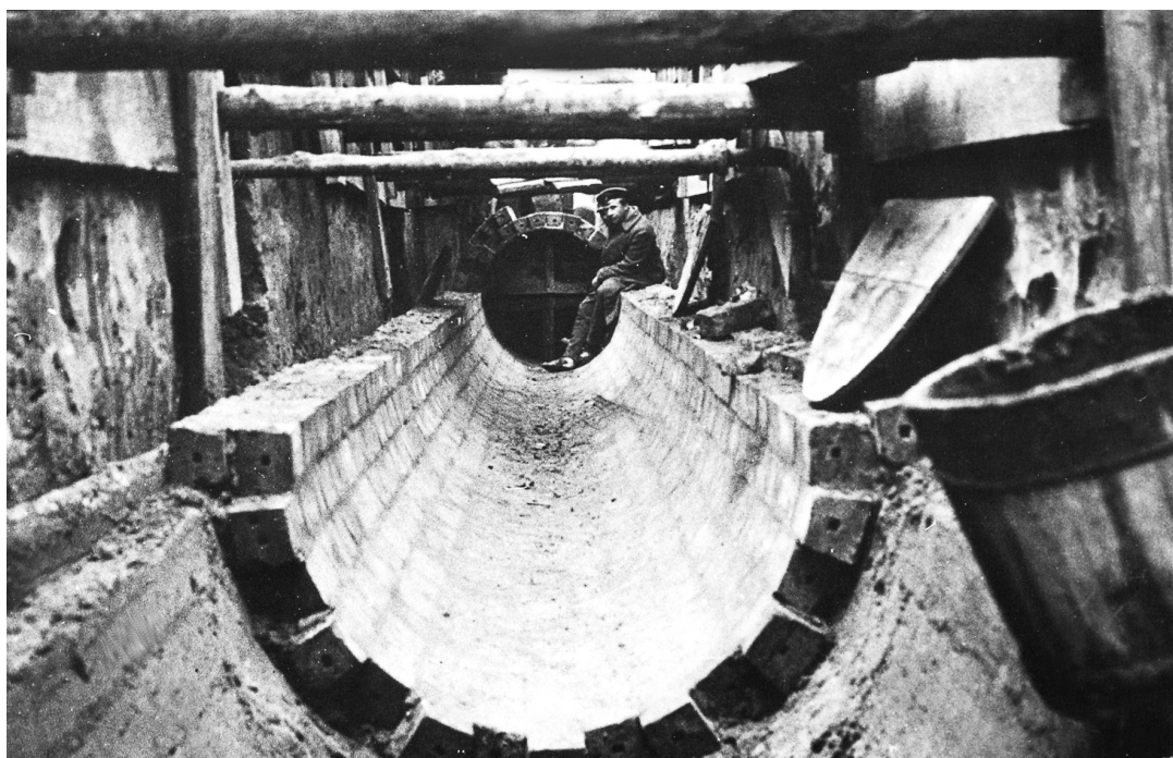
Рис. 1.11. Канализационный коллектор в Харькове в процессе строительства (1914 г.).
