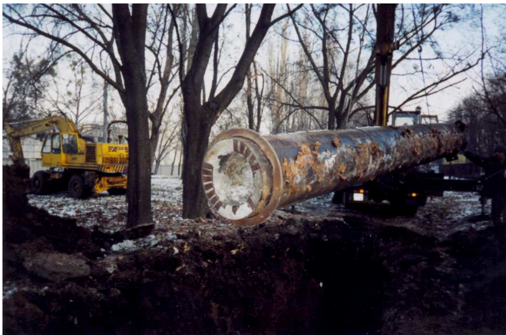
Рис. 6.26. Монтаж трубы с подготовленным фланцевым соединением.
