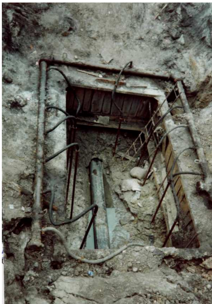
Рис. 7.23. Протягивание полиэтиленовой трубы в разрушенный трубопровод
