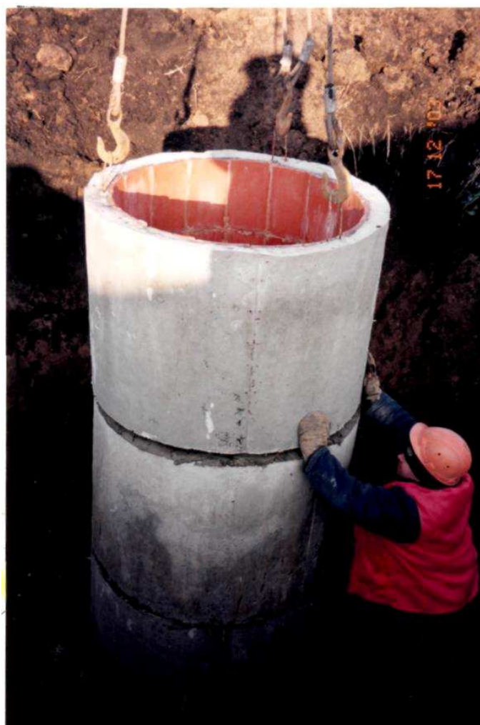
Рис. 9.3. Монтаж третьего кольца смотрового колодца.
