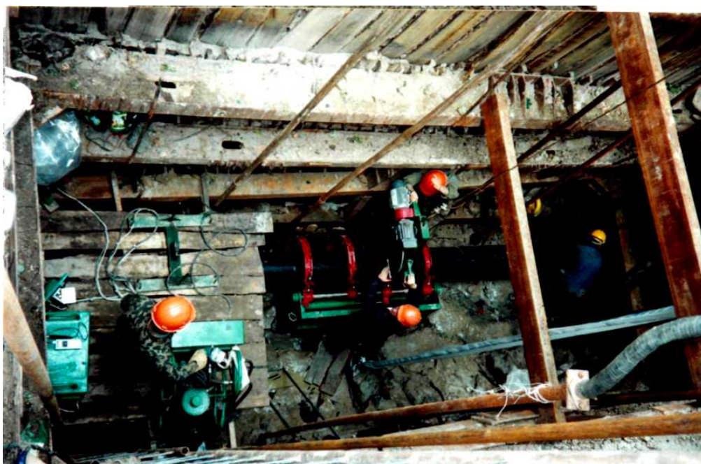
Рис. 7.24 Соединение труб с помощью сварки.
