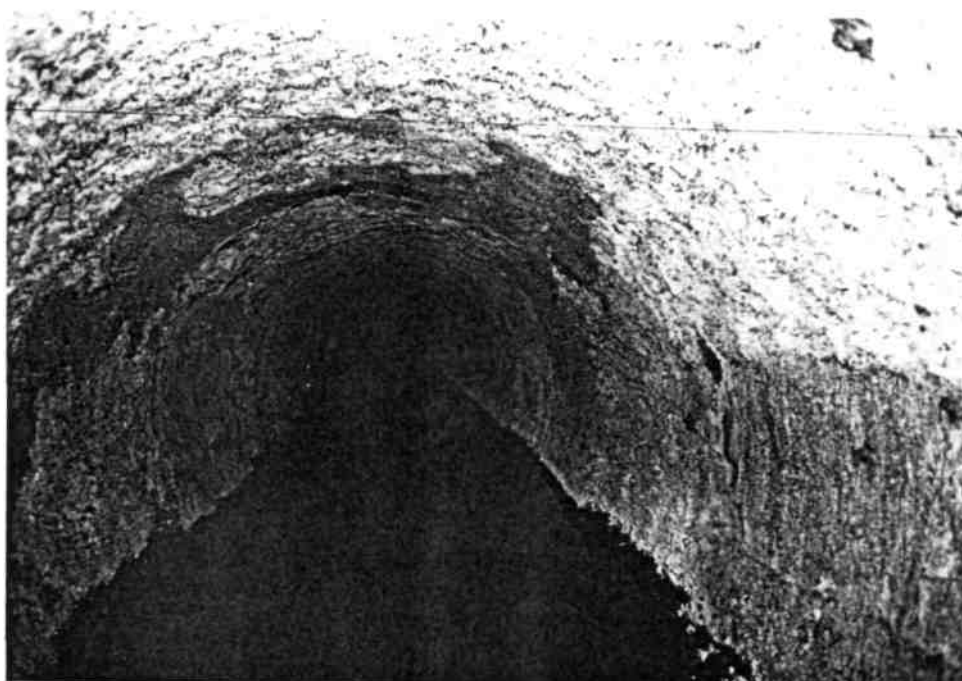
Рис. 4.7. Общий вид тоннельного коллектора с поврежденным сводом.
