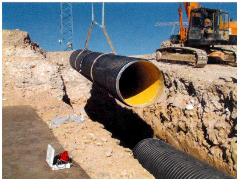
Рис. 6.1. Укладка трубопровода производства фирмы FIRAT FKS без крепления траншеи.
