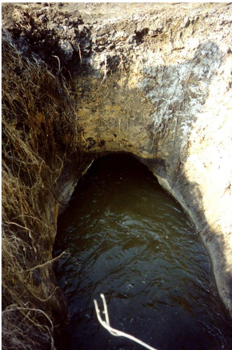
Рис. 6.10. Орджоникидзевский коллектор с разрушенной коррозией сводовой частью.
