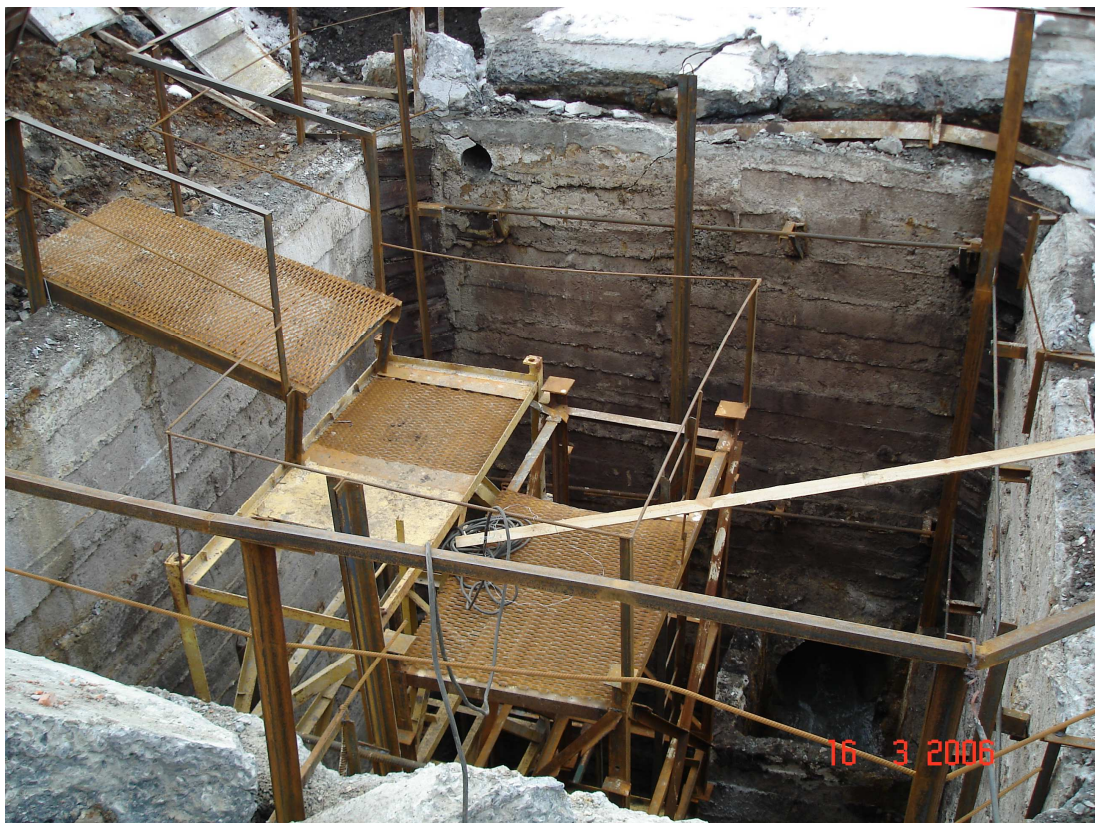
Рис. 9.24. Общий вид обустроенной строительной площадки смотровой шахты перед началом ремонтно-восстановительных работ.
