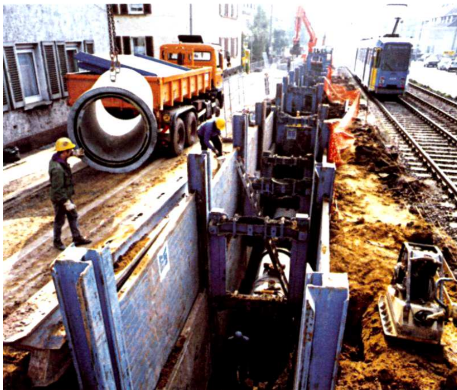
Рис. 6.3. Укладка трубопровода в укрепленный опалубочные (Э+Ш) траншеи.
