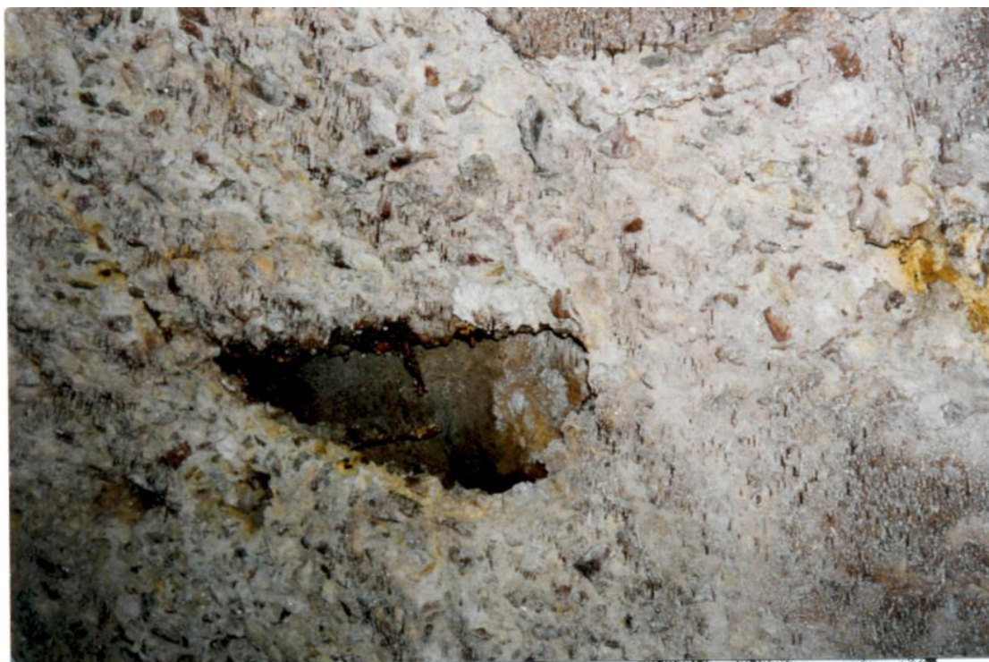
Рис. 4.9. Начальная стадия коррозии железобетонных тубингов
