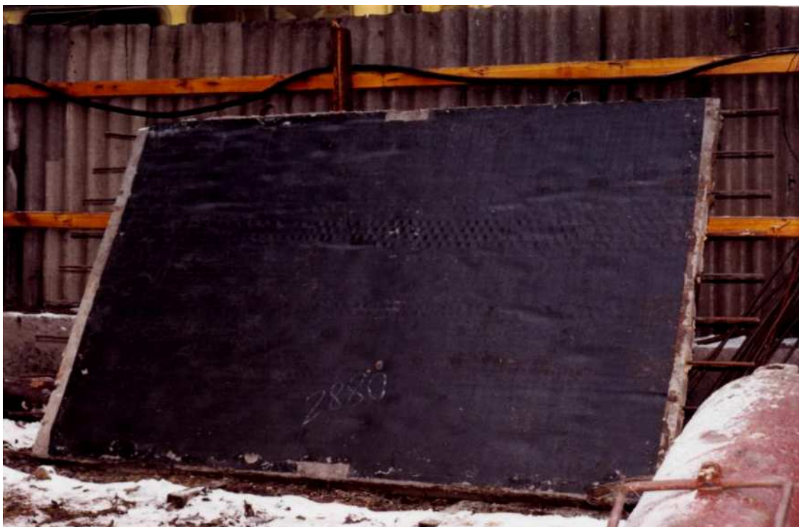
Рис. 9.4. Железобетонная панель облицованная в заводских условиях ребристым полиэтиленом.
