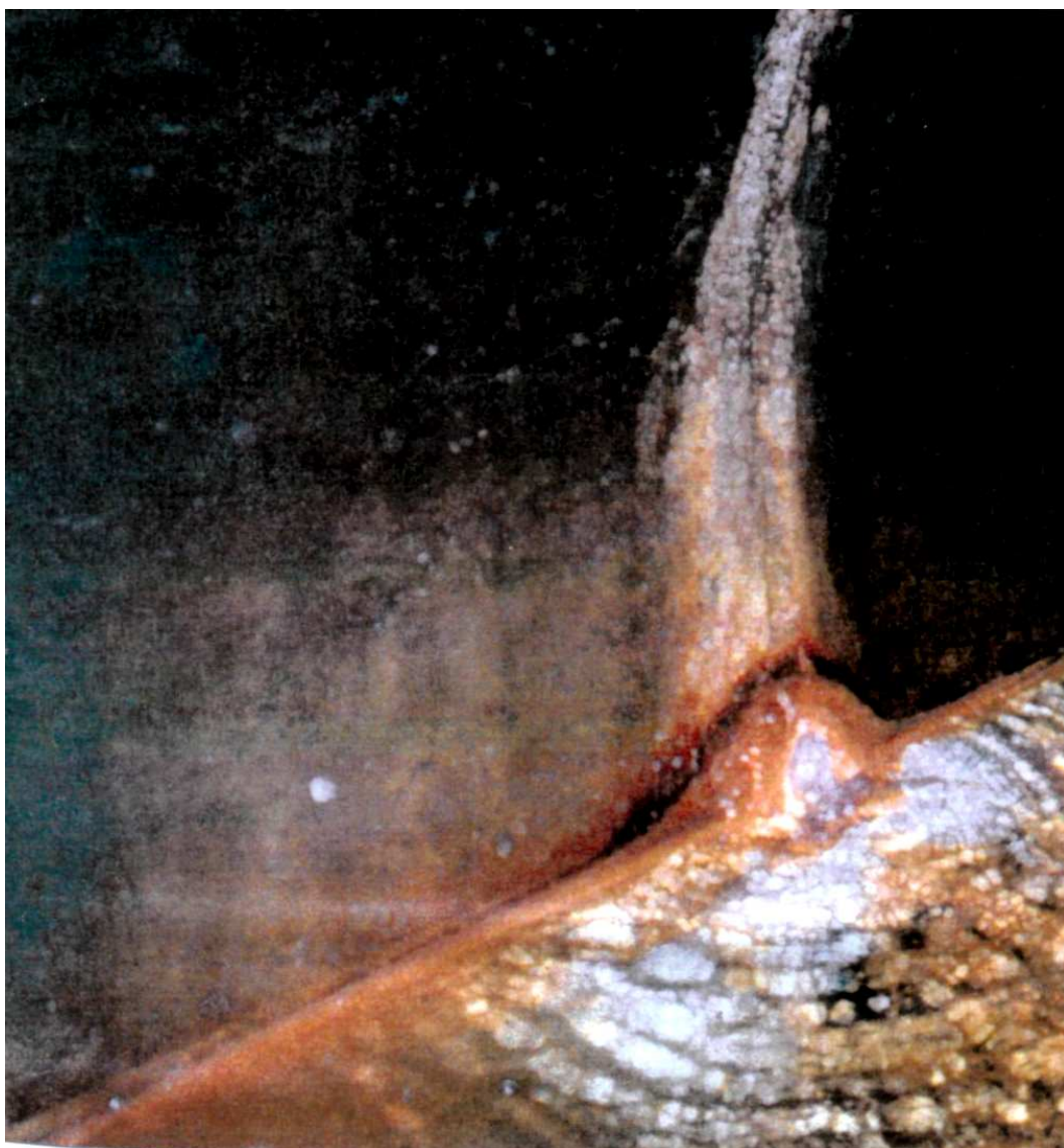
Рис. 3.13 Вынос песка в коллектор через разрушенные стыки.
