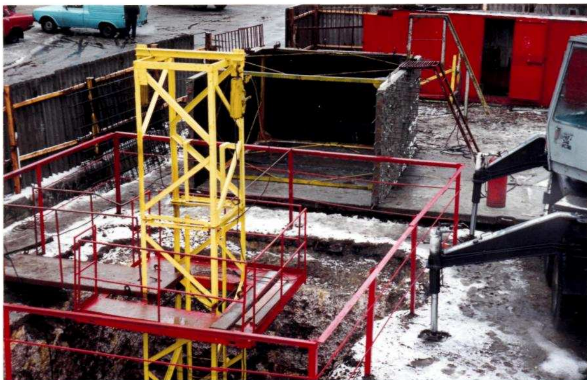
Рис. 9.5. Монтаж блока из облицованных ребристым полиэтиленом железобетонных панелей.
