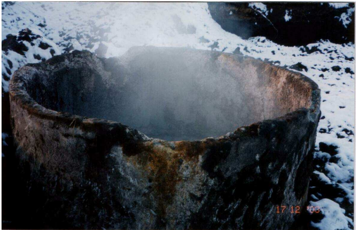
Рис. 9.1 Смотровой колодец после пятилетней эксплуатации.
