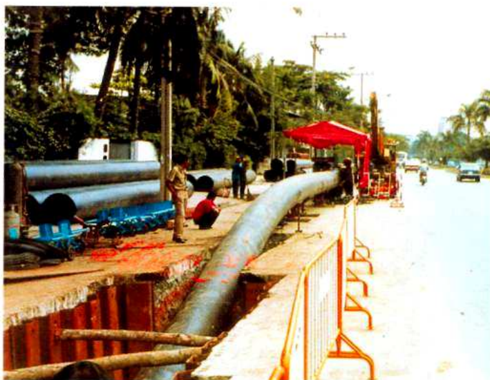
Рис. 7.21. Использование метода Relining при восстановлении канализационного коллектора в Бангкоке (Тайланд) диаметром 355...710 мм, длина коллектора 9300 м.
