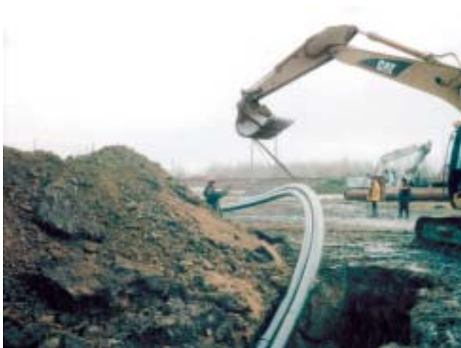
Применение ПЭ труб при строительстве сетей напорного водоотведения, Санкт-Петербург, Таллинское шоссе
