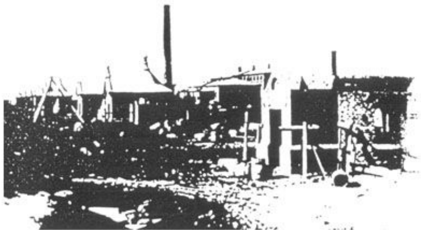
Строительство колодцев медленных фильтров станции «Днестр»
