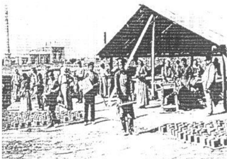
Изготовление дырчатых плит и кубиков для дренажа медленного фильтра №11, 1913 г.
