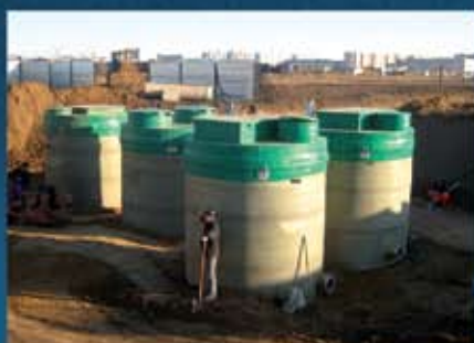
Монтаж КНС обводного коллектора г. Уральск, Q = 3100 м³/ч
