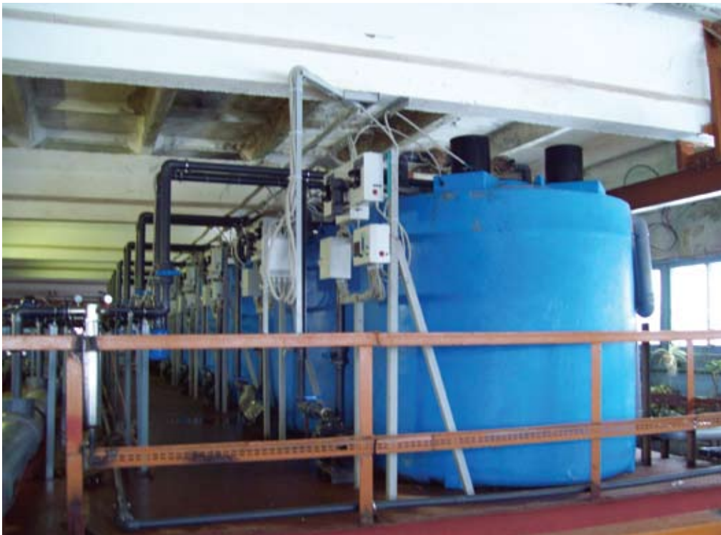
Рисунок 4 Уварово, Тамбовская обл. ВЗУ 6200 м 3 /сутки. Железо в исходной воде до 2.5 мг/л. Железо в очищенной воде - ниже порога определяемости, полная стерилизация. Семь независимых линий. Полное отсутствие затрат на регламент. Автомат.
