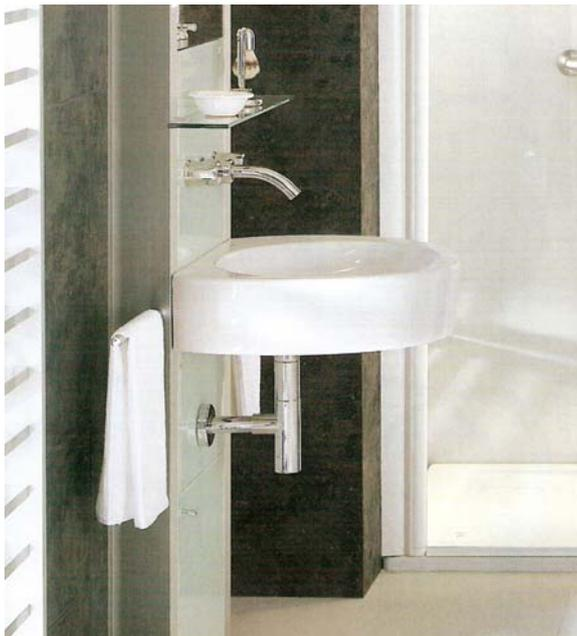
Рис. 4.9.8. Установка умывальника с открытым сифоном.
