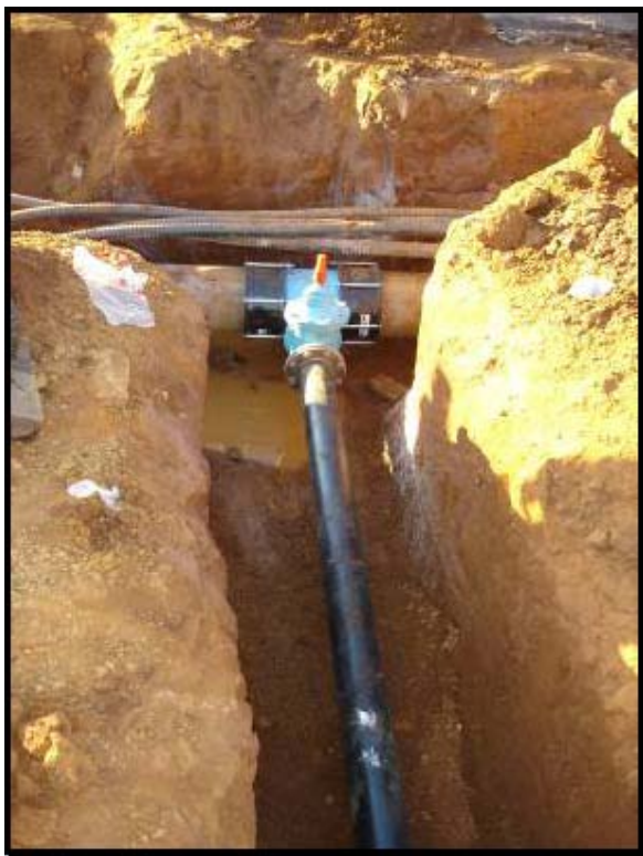
Иллюстрация 5: Установка недостающей "Т-части" в Sebokeng
