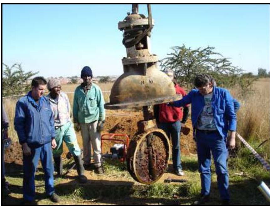
Иллюстрация 7: Удаление тела клапана
