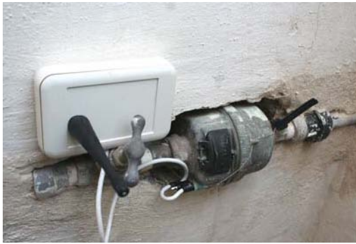
Иллюстрация 4: ZigBee AMR Приемответчик Запирался на Водный Метр
