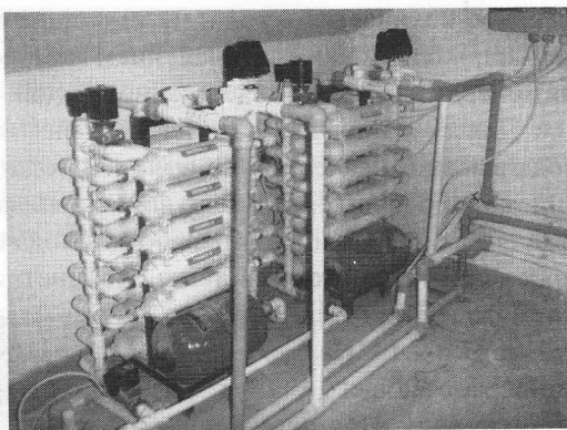
Рис. 4.14. Установки ультрафильтрации для очистки горячей и холодной воды в жилых зданиях
