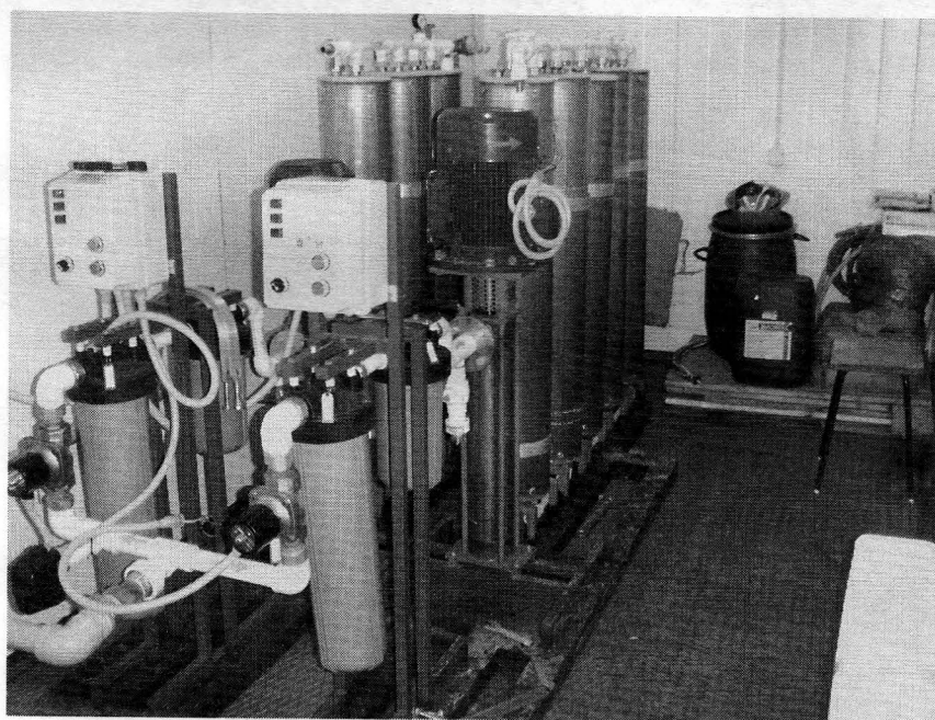
Рис. 4.5. Станция очистки подземных вод от железа и аммония производительностью 200 м 3 /сут (Салымское месторождение, 2006 г., изготовитель – ООО «Комплект Экология»): а – внешний вид станции; б – мембранная установка
