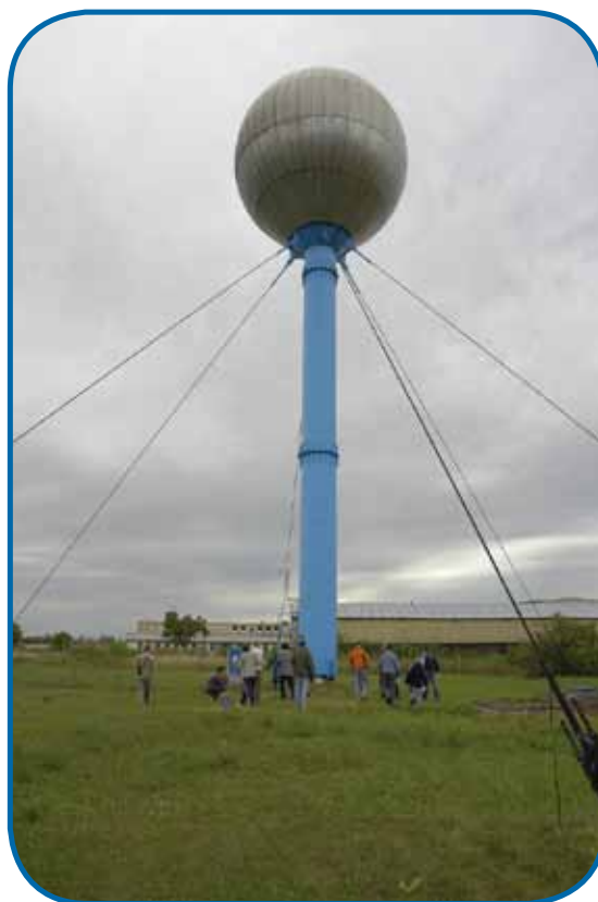
Водонапорная башня, снабжающая водой маленькую деревню в Южной Моравии, Чешская Республика
