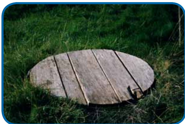
Колодец с деревянной крышкой до обновления
