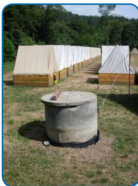
Колодец с улучшенной герметичной крышкой для снабжения водой летнего молодежного лагеря, Западная Богемия, Чешская Республика
