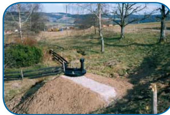
Колодец после обновления
