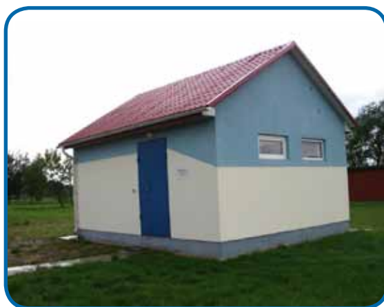
Помещение для колодца сельской общественной системы водоснабжения, Литва © UBA, Дессау-Розлау (Германия)/Oliver Schmoll
