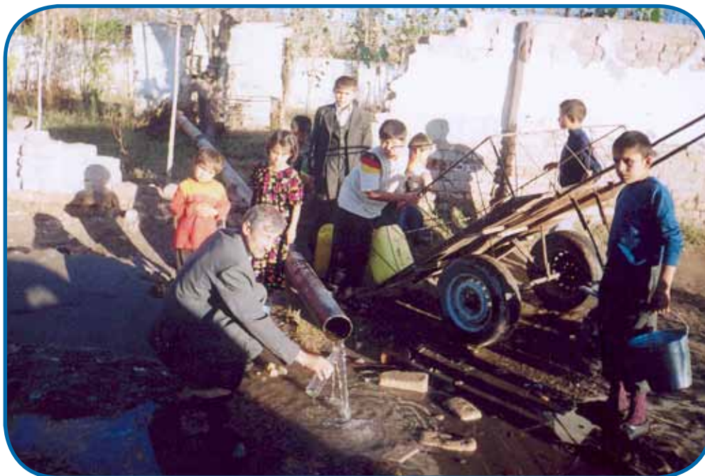
Поврежденная система водоснабжения в Фархорском районе Хатлонской области, Таджикистан
