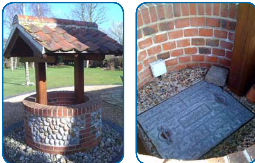
Стальная крышка люка для современного домашнего колодца, Норфолк, Англия © Университет Восточной Англии, Норидж (Соединенное Королевство)/Helen Risebro
