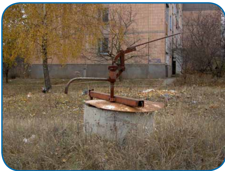
Колодец общего пользования для жителей многоквартирных домов.
