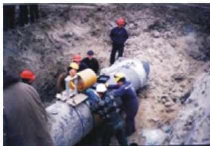
Рис. 3.27. Ремонт подземного участка МТ
