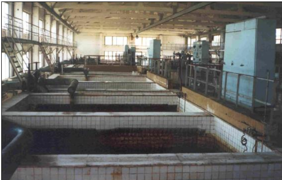
Рис. 7.8. Зал станции обезжелезивания воды в г. Томске
