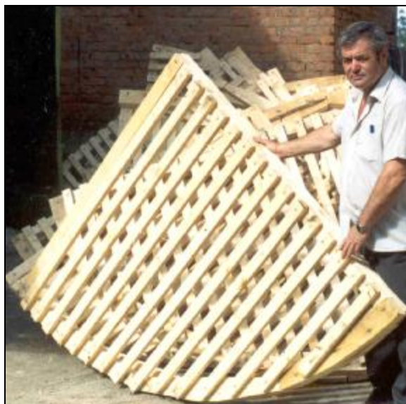
Рис. 7.6. Фрагмент деревянной хордовой насадки градирни-дегазатора
