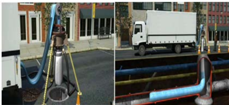
Fig. 5.37. - Faze din tehnologia CIPP
