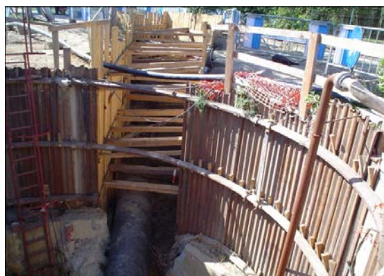
a) Fig. 1.2. a)-Realizarea a două colectoare de 1200 mm prin metoda scutului, TT; b)-Realizarea unei artere Dn 800 în săpătură deschisă
