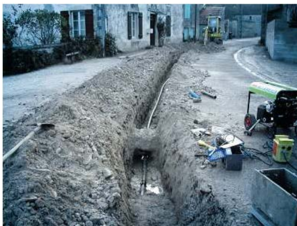
Fig. 1.3. Șantier pe o stradă folosind tehnologia clasică la executarea unui colector de canalizare sub presiune
