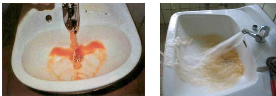
Fig. 5.15. - Producerea de apă roșie la robinet
