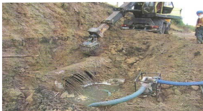
Fig. 5.23. - Corodarea armăturii la tuburile PREMO a condus la explozia tubului
