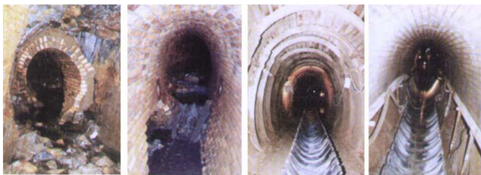
Fig. 5.10. - Colectoare din zidărie fără și cu protecție anticorrosivă
