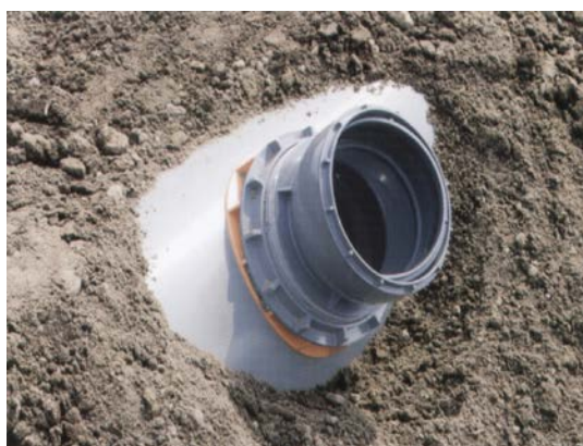
Fig. 5.53. – Racordarea, cu piesă prefabricată, din exterior
