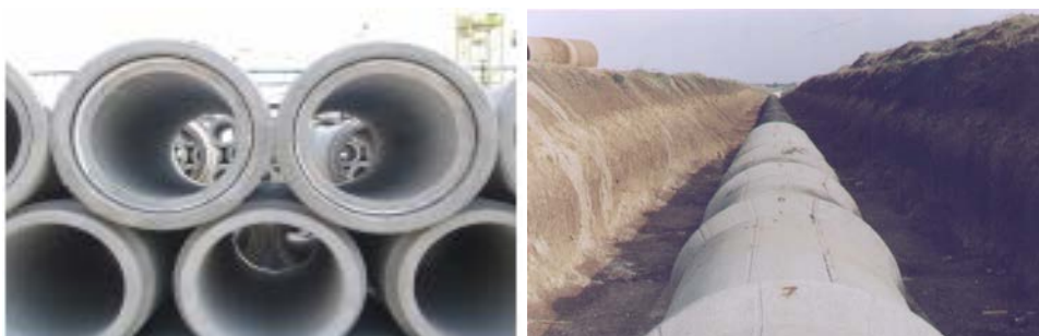
Fig. 5.8. - Tuburi de beton îmbinate cu mufă și garnitură de cauciuc
