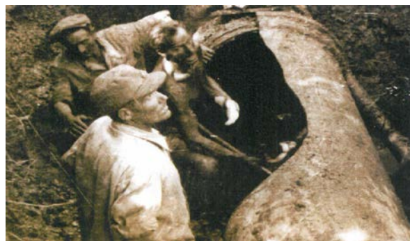
Fig. 5.19. - Expluzarea unei bucăți de tub de fontă cenușie
