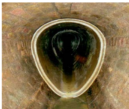
Fig. 5.41. – Cochilie din fibră de carbon, poliestere armat cu fibră de sticlă așezată în tubul vechi
