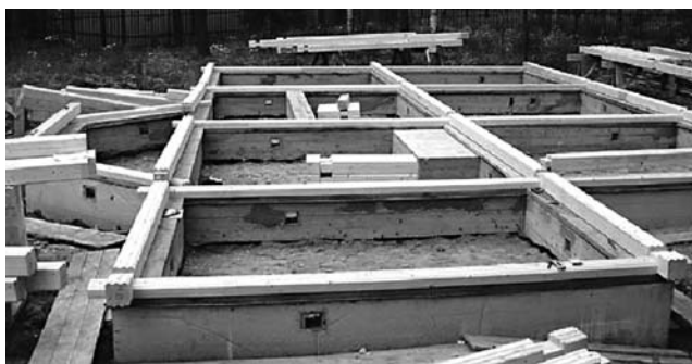
Рис. 2.15. Ленточный фундамент в готовом виде
