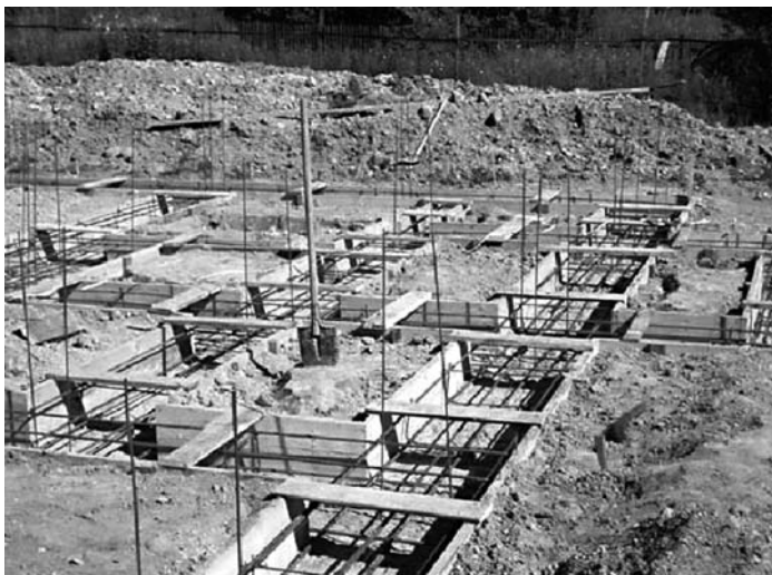
Рис. 2.3. Пространственный каркас из стальных стержней арматуры готов к заливке монтажного бетона
