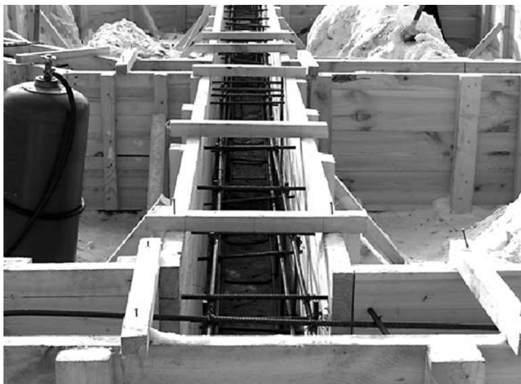
Рис. 2.2. Арматуру опалубки необязательно сваривать, дешевле и проще ее связать
