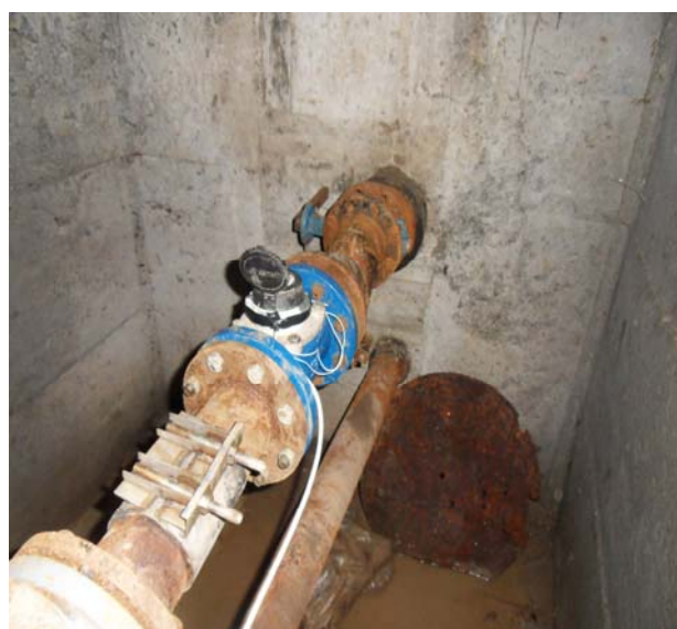
Фигура 10.33 Зонова шахта на DMA КООПЕРТИВЕН ПАЗАР (Водомер – PRV)
