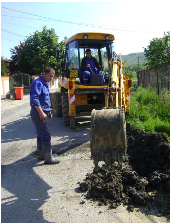
Фигура 6.20 Отстраняване на течове
