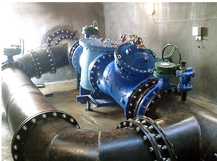
Фигура 10.12 Шахта с регулатор на налягането на фирма „Bermad“ с необходимите арматури и устройства
