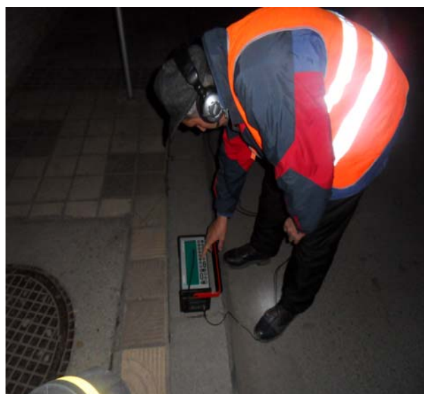
Фигура 6.19 Използване на корелатор за откриване на теч
