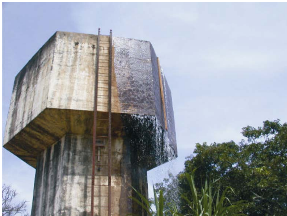
Фигура 3.5 Преливащ резервоар
