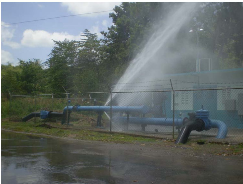
Фигура 3.19 Теч в помпена станция
