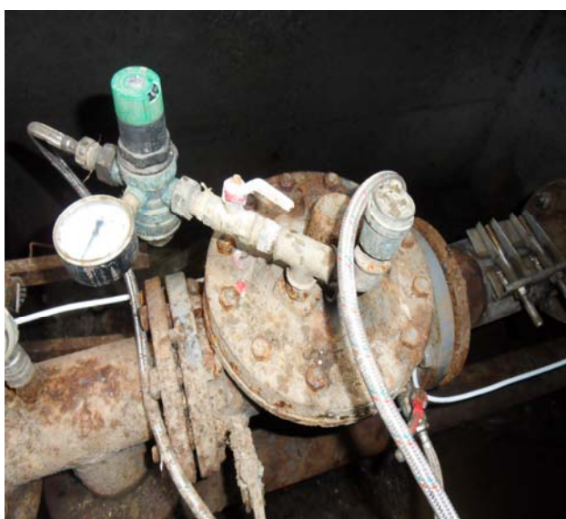
Фигура 10.33 Зонова шахта на DMA КООПЕРТИВЕН ПАЗАР (Водомер – PRV)
