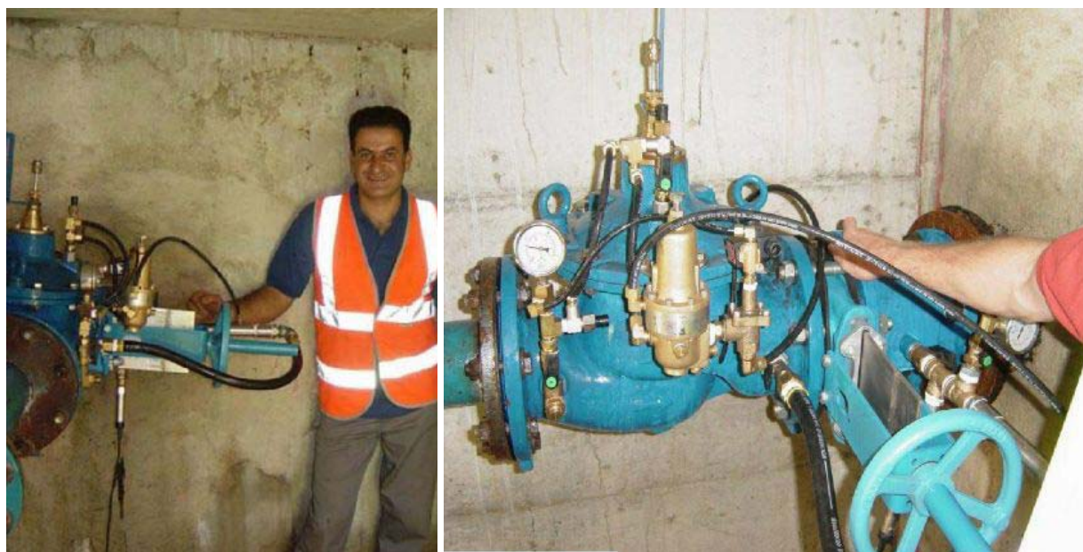
Фигура 10.19 Снимки на PRV вентил за модулация по дебит и с хидравличен контрол
