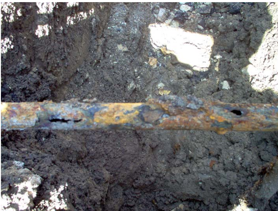
Фигура 3.4 Сградно водопроводно отклонение
