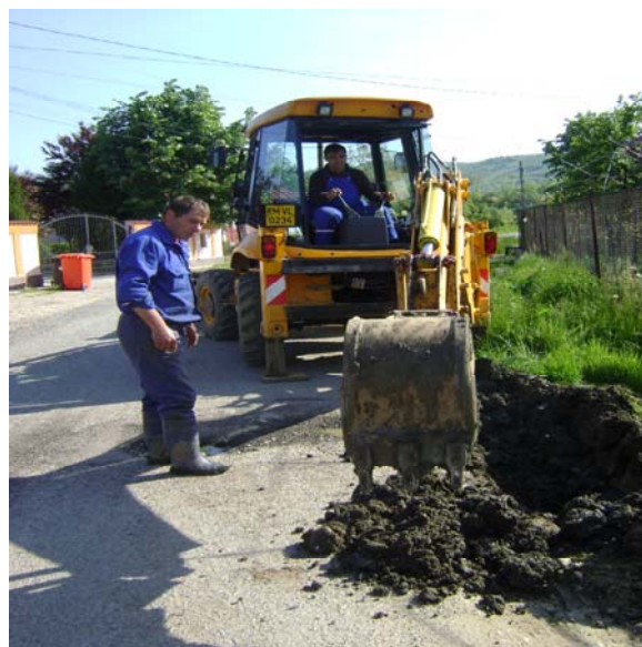
Фигура 10.44 Отстраняване на теч 3.4 l/s в подзона 5 - DMA Кооперативен пазар
