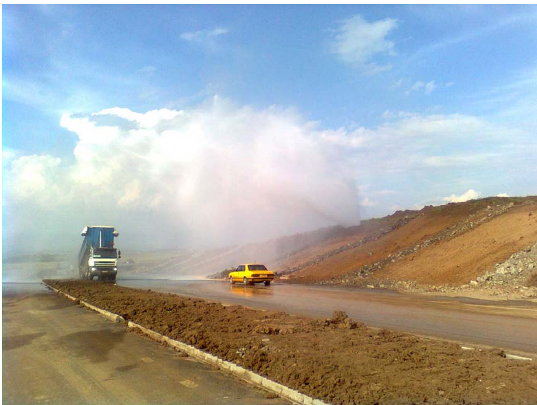
Фигура 1.6 Авария на главен водопровод
