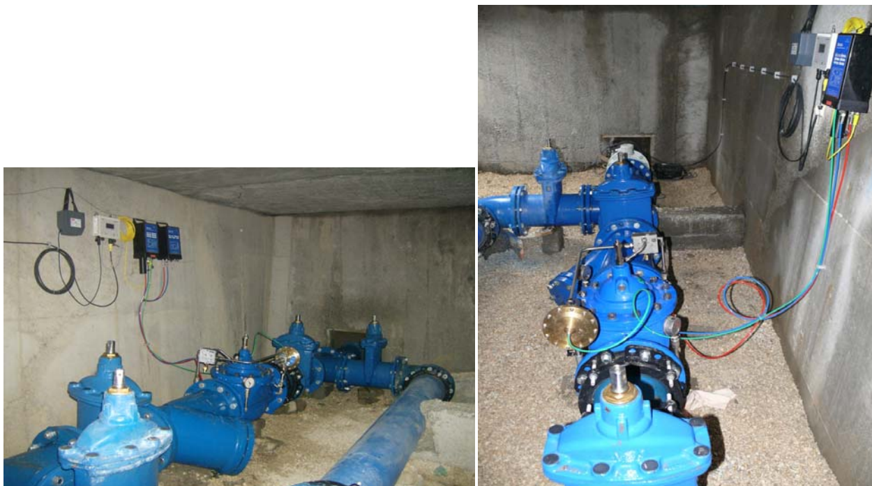
Фигура 10.2 Разходомер и камера за регулиране на налягането
