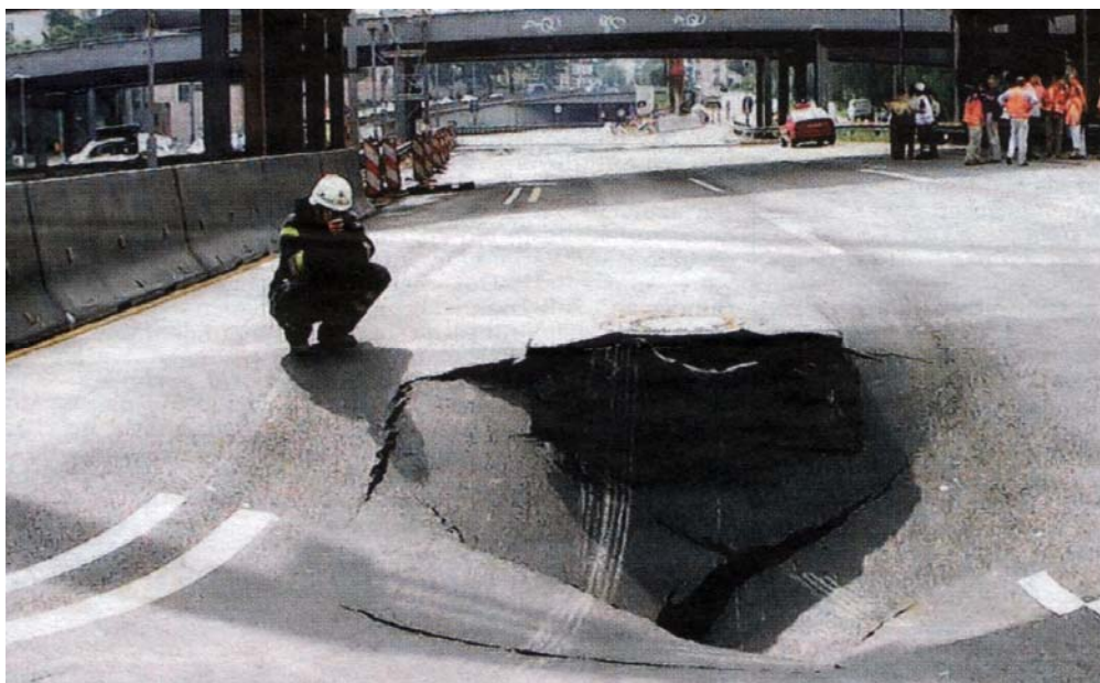
Фигура 3.21 Хлътване на пътна настилка
