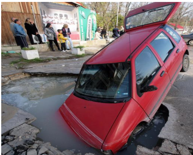
Фигура 3.13 Хлътване на пътна настилка
