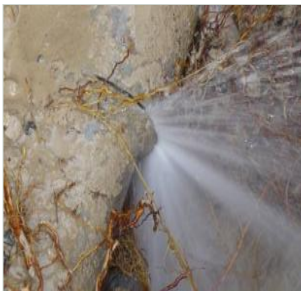
Фигура 10.44 Отстраняване на теч 3.4 l/s в подзона 5 - DMA Кооперативен пазар
