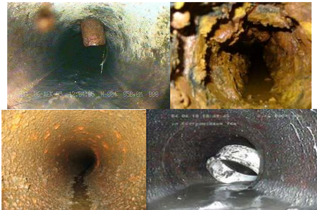
Рис.6. Дефекты трубопровода, обнаруженные телероботами
