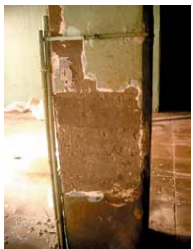
ОЧИСТКА КОЛОННЫ ОТ СТАРЫХ СЛОЕВ КРАСОК И ШТУКАТУРКИ
