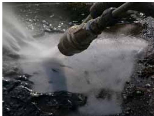
ОЧИСТКА НАРУЖНОЙ ПОВЕРХНОСТИ ТРУБЫ ПРИ ПОМОЩИ АБРАЗИВА
