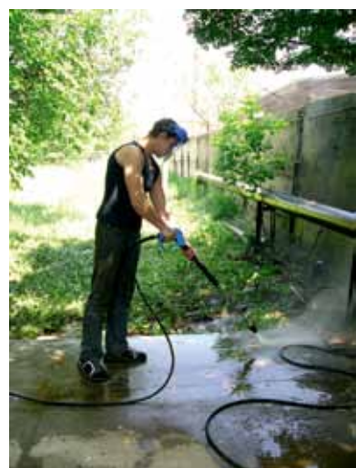
ОЧИСТКА БЕТОННОГО ОСНОВАНИЯ ПРЕД РЕМОНТОМ
