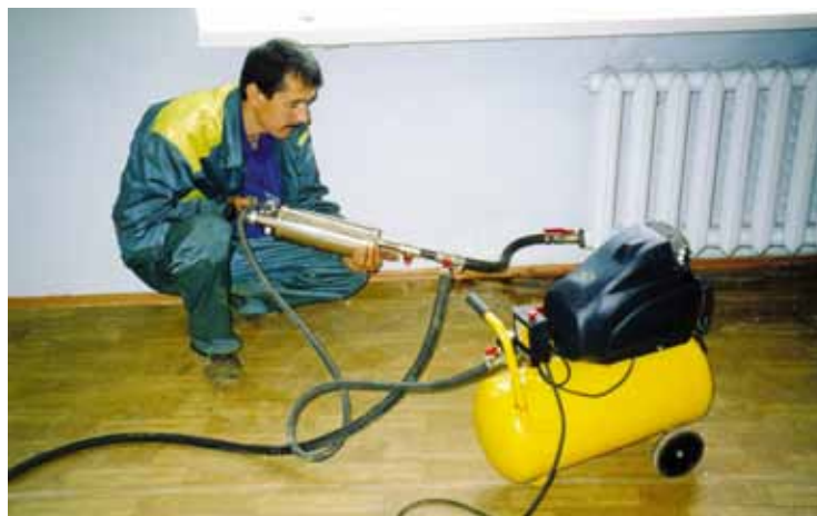
ОЧИСТКА РАДИАТОРА ОТОПЛЕНИЯ
