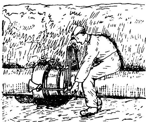
← Fig. 43. Tragerea mufei cu ajutorul cricului cu șurub.
