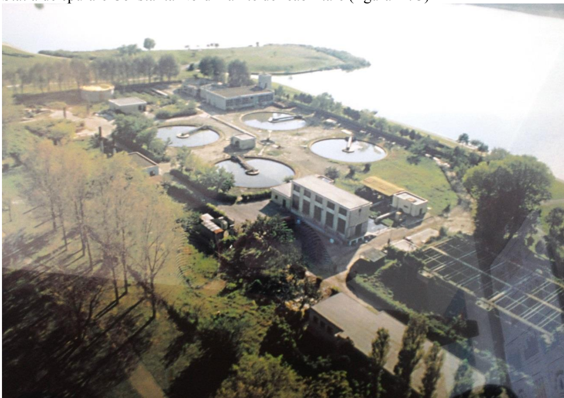
Statia de epurare Constanta Nord înainte de reabilitare (figura nr. 3)
