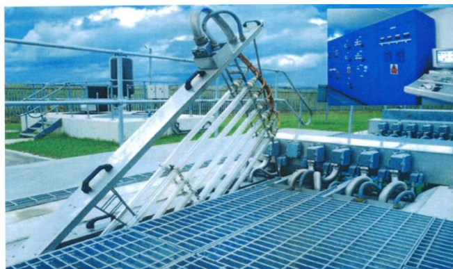
Fig. 2. Instalație de tratare cu UV montată în canal
