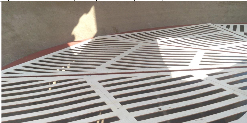
Fig. 7 - Montare Disc 2 în camera tronconică-decantor radial
