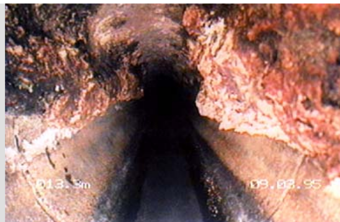
Inkrustation nach erster Reinigung, großflächig
