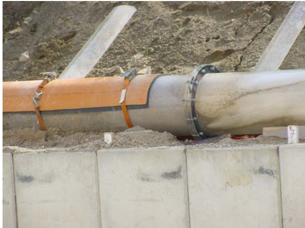
Bild 76: Düse bleibt stecken, DN 300
