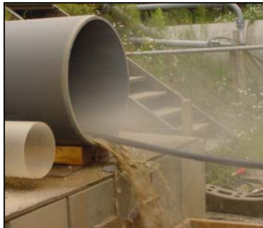
Bild 61: Einspülen der Düse
