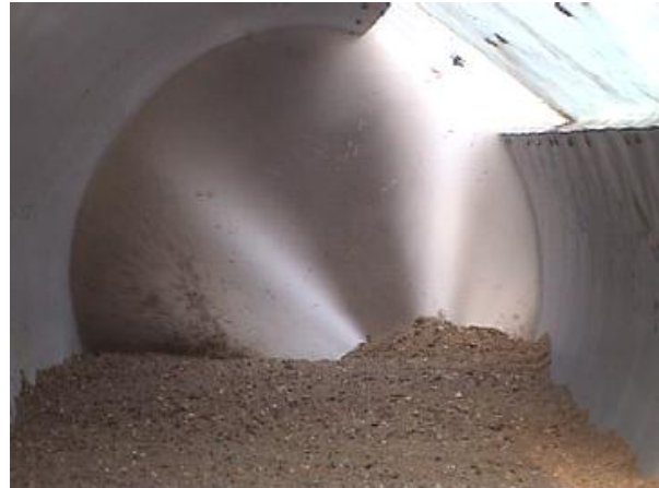
Bild 77: Düse bleibt stecken, DN 800
