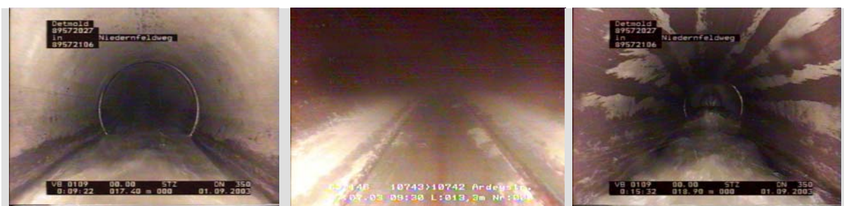
Bild 18: Sielhaut vor der Reinigung (links), Sielhautstreifen nach der Reinigung, Bildbeispiele (mitte und rechts)
