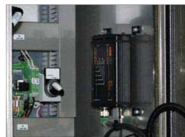
Модуль GSM - обеспечивает быстрый доступ для диагностики навесного оборудования с завода-изготовителя
