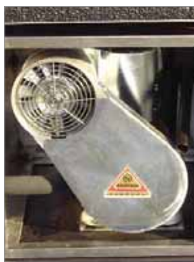
Компрессор для забора осадка с глубины до 25 м
