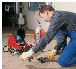
Определение местоположения камеры по звуковому сигналу и показаниям прибора
