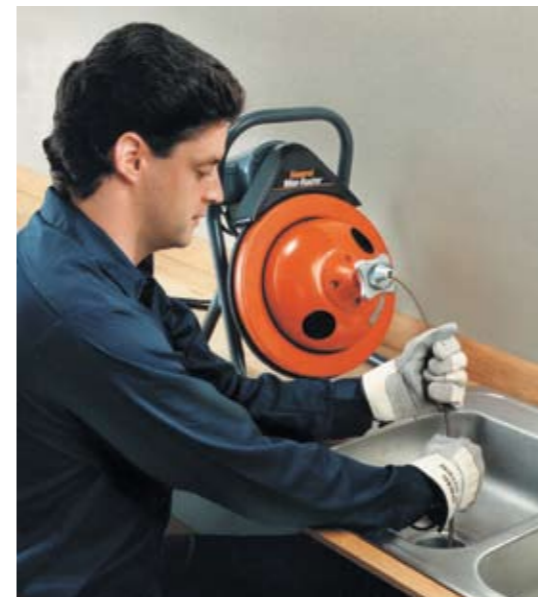
Прочистка слива раковины с использованием спирали 6,4мм в барабане (J50)
