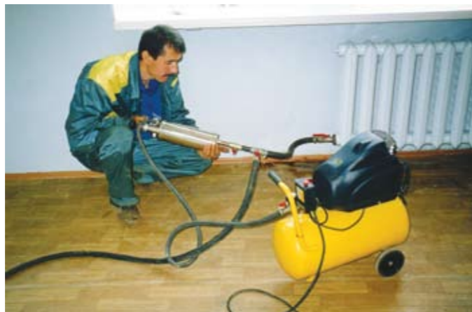
Очистка радиатора отопления
