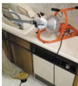
Прочистка слива раковины
