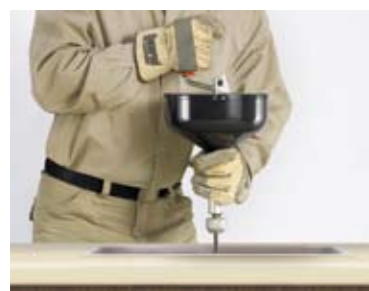
Прочистка слива раковины
