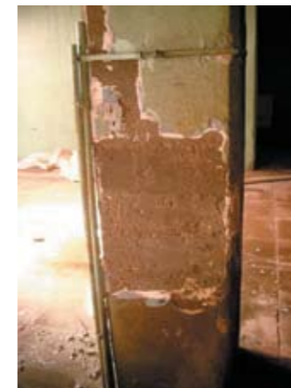
Очистка колонны от старых слоев красок и штукатурки
