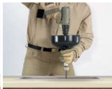
Прочистка с использованием электродрели
