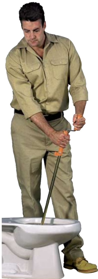
Прочистка засора унитаза
