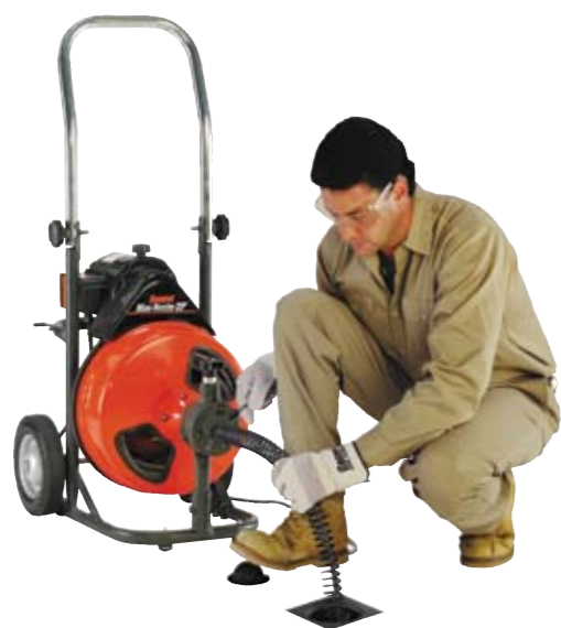
Очистка слива. Оператор управляет скоростью подачи спирали
