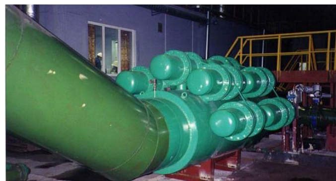
СД-25-1000 на системе охлаждения валков и машин чистой группы, ЛПЦ-2 ОАО «Северсталь»
