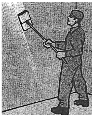
Рисунок 16 – Шлифовка отшпатлеванных мест шарнирной теркой
