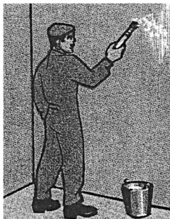
**Рисунок 14 – Огрунтовка отшлифованных мест**
