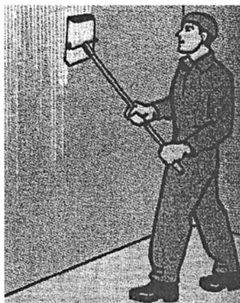
Рисунок 7 – Очистка поверхности с помощью шарнирной терки
