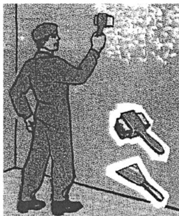
Рисунок 6 – Очистка поверхности стен с помощью металлического скребка и лещади
