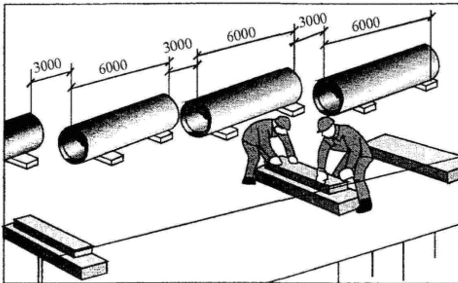
Монтажники Т<sub>3</sub> и Т<sub>4</sub> натягивают рулетку вдоль оси раскладки звеньев и размечают по ней положение лежней, после чего подносят лежни и раскладывают их по разметке так, чтобы середина лежней совпала с осью раскладки. По концам крайних лежней забивают четыре стальных стержня и натягивают между ними шпагат на уровне верха крайних лежней. Затем, предварительно сдвинув промежуточные лежни, укладывают их по уровню крайних, срезая или подбивая лопатами грунт под ними.
