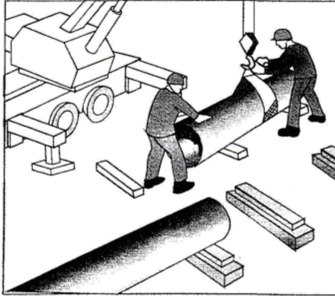
Убедившись в правильности строповки и надежности действия тормозов, он продолжает подъем на высоту до 1 м, после чего по команде стропующего укладывает трубу на лежни так, чтобы ее стыкуемый конец находился примерно на равном расстоянии от промежуточных лежней.
