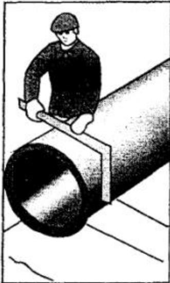
2.15 После окончательной выверки и увода стрелы с траверсой и стропами из зоны монтажа трубы (звена) монтажники Т<sub>1</sub>, Т<sub>2</sub>, Т<sub>3</sub> и Т<sub>4</sub> лопатами подбивают трубу грунтом на высоту  $\frac{1}{4}$  ее диаметра с послойным уплотнением ручными трамбовками. Толщина уплотняемого слоя грунта не должна превышать 25 - 30 см.
