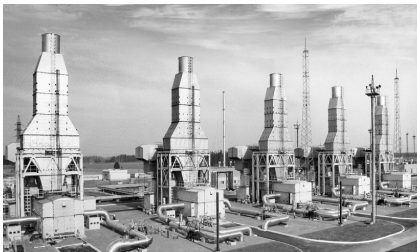
Рисунок 3 - Компрессорная станция природного газа на основе агрегатов типа ГПА-Ц-16С (газопровод Ямал-Европа, ОАО "Белтрансгаз", КС "Несвиж")
