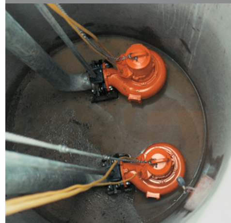
Montajul imersat Wet sump installation Behälteraufstellung
