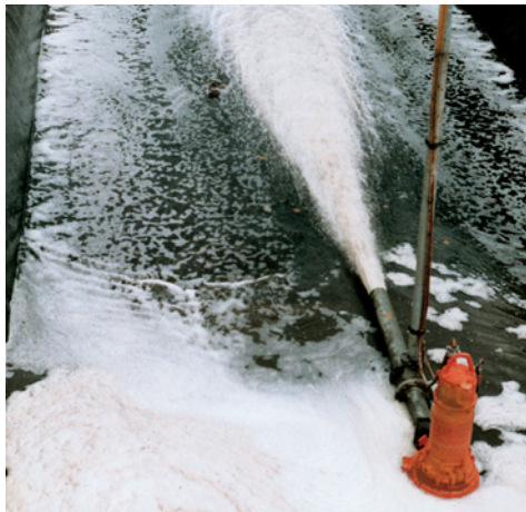
Curățirea directă la fundul bazinului Cleaning directly at the tank bottom Reinigung direkt am Beckenboden
