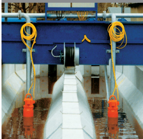
Captatoare de nisip cu capete de agitare WILO-EMU Grit collector with WILO EMU mixer heads Sandfang mit WILO EMU Rührköpfen
