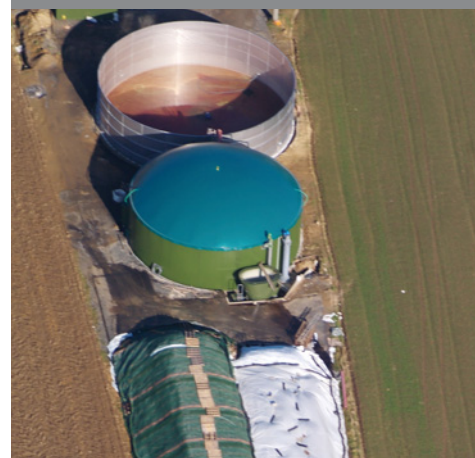
Instalație de biogaz Biogas installation Biogasanlage
