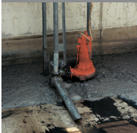
Curățirea unui bazin pentru ape pluviale Cleaning of storm water retaining basins Regenbeckenreinigung
