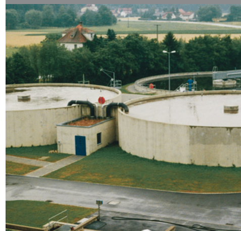
Pomparea apelor uzate cu conținut de nitrați Pumping of sewage containing nitrate Förderung von nitrathaltigen Abwasser
