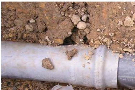
Иллюстрация 5 Типичный ремонт просачивающегося соединения
