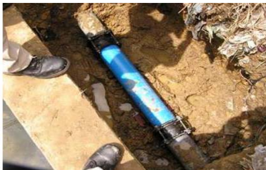
Иллюстрация 5 Типичный ремонт просачивающегося соединения
