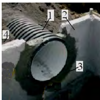
Рисунок 9.56 – Провод трубы «КОРСИС ПРО» через стенку бетонного прямоугольного колодца
