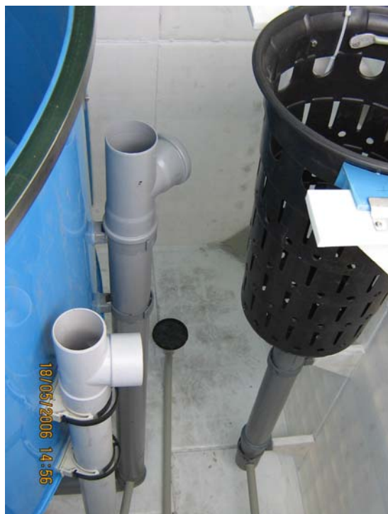
Fig. nr.4.10 Stație de epurare compactă BIO CLEANER: a- zona de denitrificare; b- decantor
