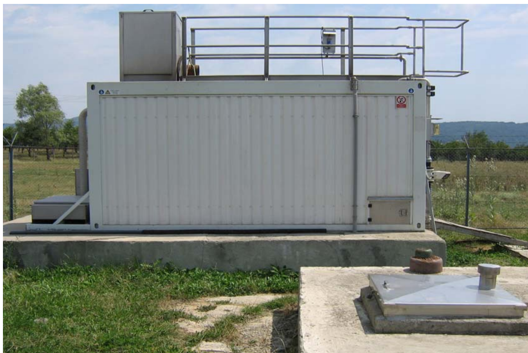
Fig. nr. 5.2 - Stația de epurare Parc Industrial Vălenii de Munte (modul biologic)
