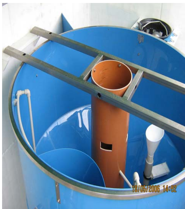
Fig. nr.4.10 Stație de epurare compactă BIO CLEANER: a- zona de denitrificare; b- decantor
