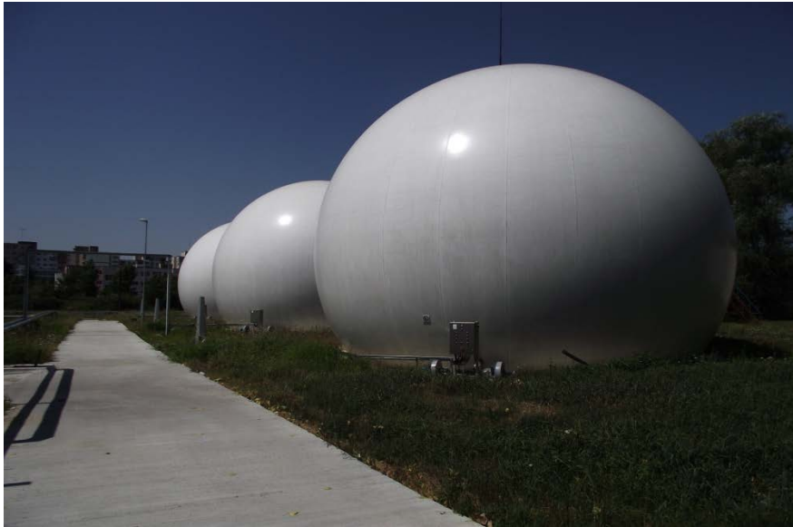
Figura 6.5 Instalații de deshidratare mecanică a nămolului
