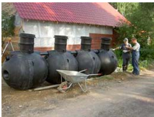
Ёмкости Уропор, объединённые в четырехкамерный септик.
