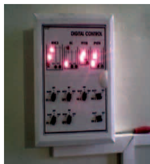
Рис. 11.14. Локальная система управления циркуляционными насосами камеры смешения и канализационно-насосной станции:
