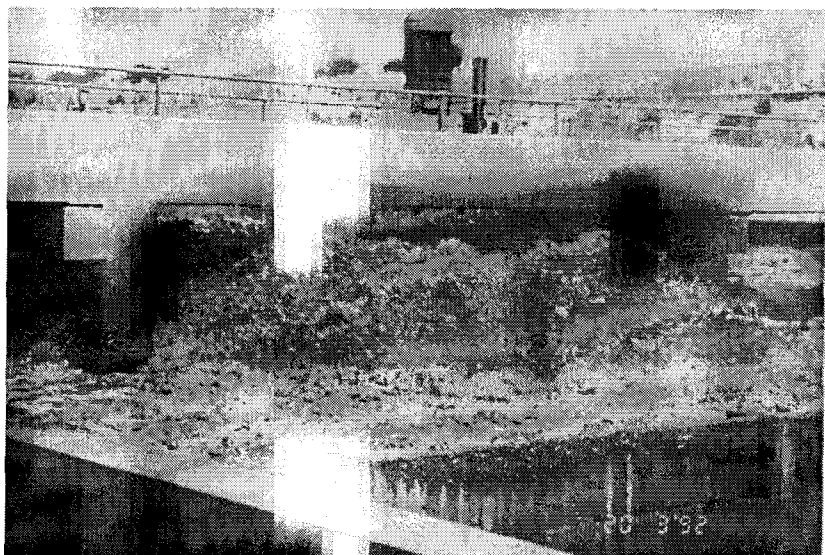
Система нитрификации с активным илом. Избыточная аэрация приводит к потерям энергии и образованию аэрозолей. Северная станция, Йоханнесбург (ЮАР).
