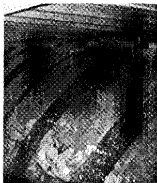
Рис. 6.19. Реакторы с вращающимися дисками для нитрификации городских стоков.
