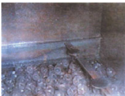
Рис. 7.11, 7.12. Загрузка биофильтра из шаровидных керамических элементов.
